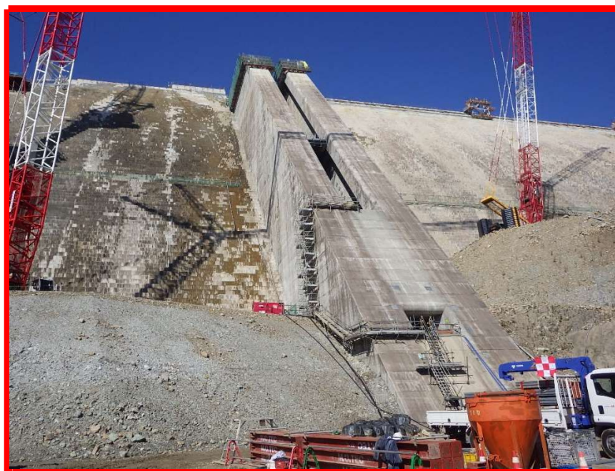
取水設備呑口部施工状況（R6. 10. 25撮影）
