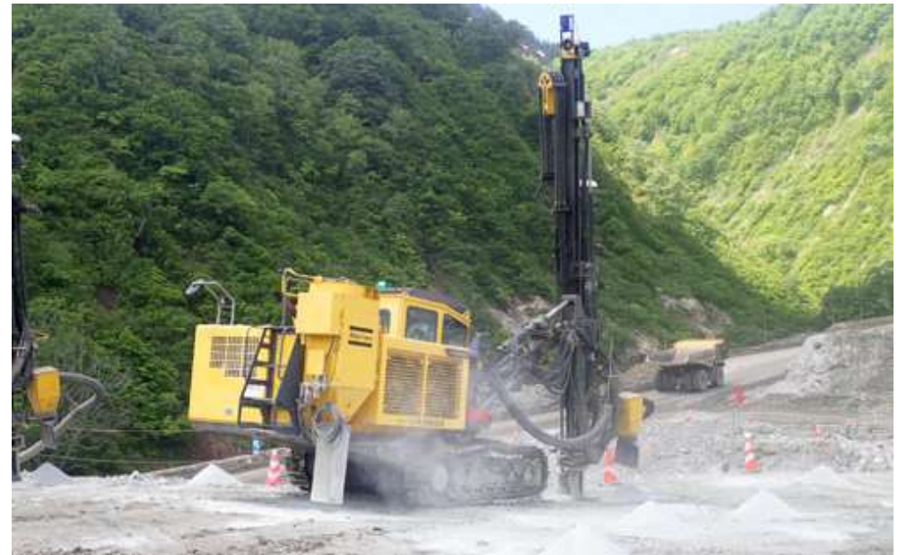
削孔中のクローラドリル
