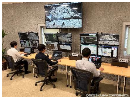
自動化施工を管制するITパイロット
