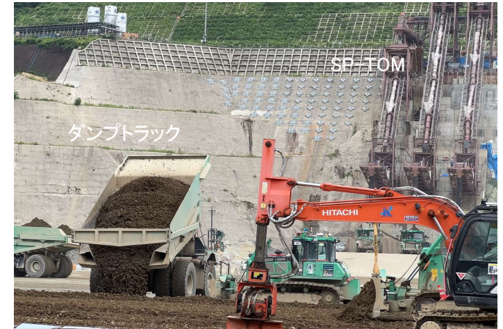
②CSG運搬（ダンプトラック） ダンプトラックにより打設を行う場所までCSGを運搬します。
