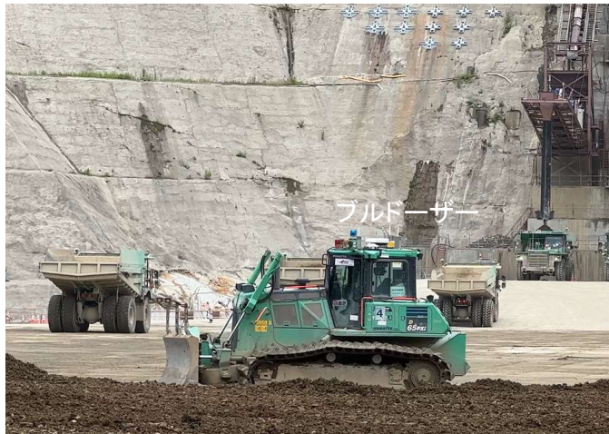
③CSG敷均し 1層25cmの厚さになるようにブルドーザーで敷均します。これを3回繰り返して75cmに敷均します。
