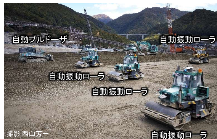
④CSG締め固め（転圧） CSGを75cm(3層)敷均した後、自動振動ローラで締め固めを行います。この工程を繰り返して成瀬ダムを建設していきます。
