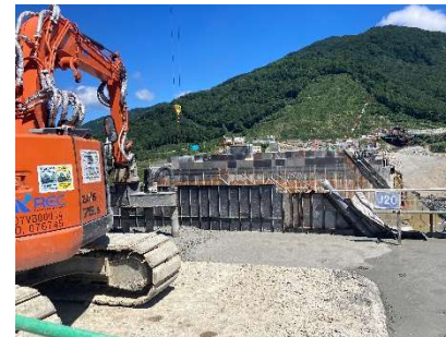
ECMコンクリート打設の様子
