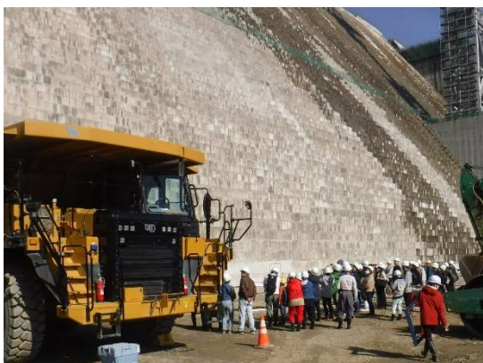
堤体間近での見学
