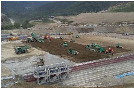
堤体C S G の打設状況
