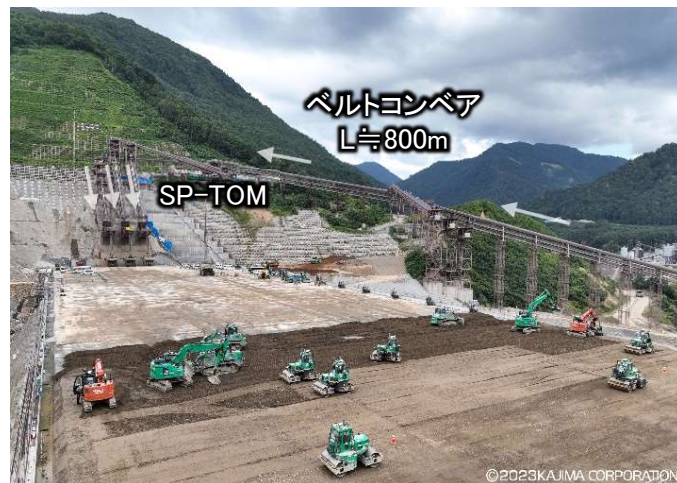
①CSG運搬（ベルトコンベア、SP-TOM※2） CSG製造プラントで製造されたCSGは、ベルトコンベア、SP-TOMでダムまで運搬します。
