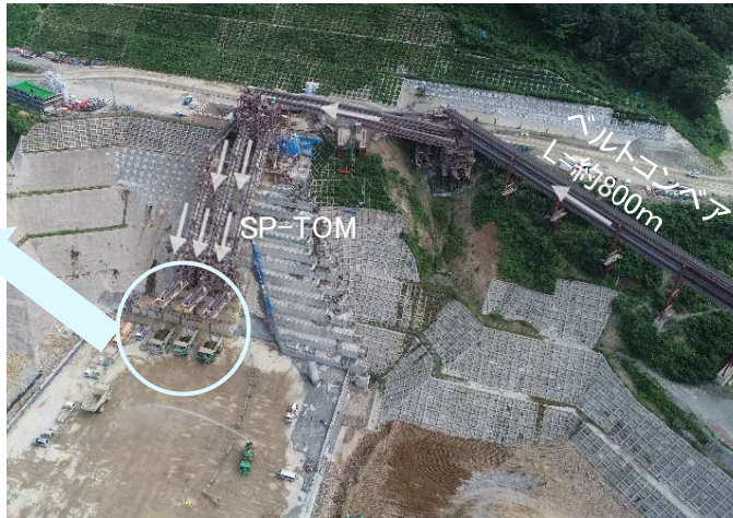
①CSG運搬（ベルトコンベア、SP-TOM※） CSG製造プラントで製造されたCSGは、ベルトコンベア、SP-TOMでダムまで運搬します。
