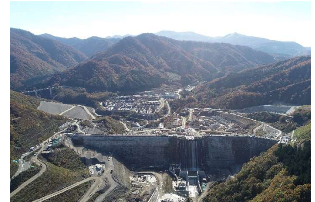
ダム堤体の進捗状況(R6.10.29現在)
