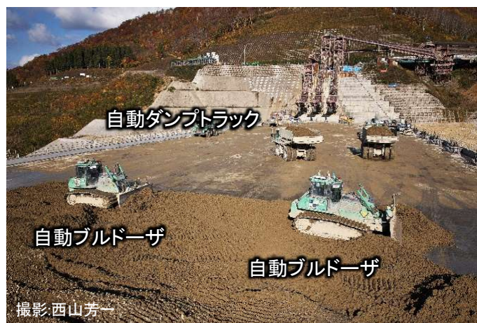
③CSG敷均し 1層25cmの厚さになるように自動ブルドーザで敷均します。これを3回繰り返して75cmに敷均します。
