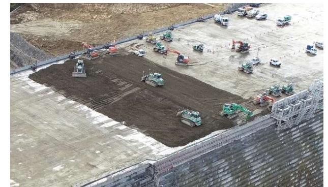
自動化施工による堤体CSG打設
