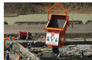
③ 堤体打設開始 令和元年10月 (撮影)
