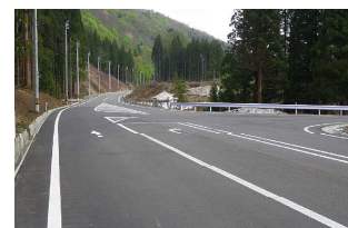
① 国道342号付替道路一次供用区間開通 平成24年4月 (撮影)
