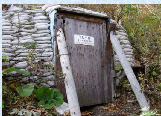
調査横坑※2の出入口状況
