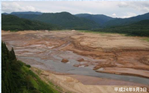
10 玉川ダム貯水池の状況 (平成24年9月：仙北市)
