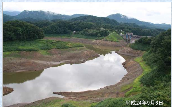
11 皆瀬ダム貯水池の状況 (平成24年9月：湯沢市)
