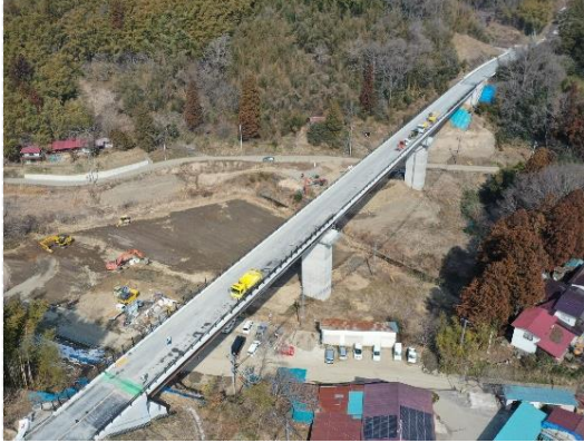
② (仮)第1号橋 完成
