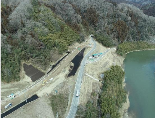
④ 道路改良工事施工中
