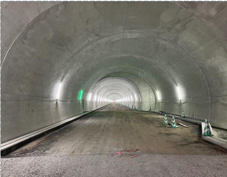
▲ トンネル坑内状況
