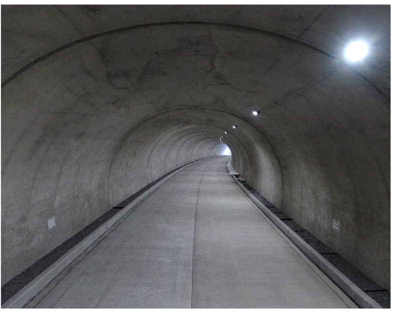
▲ トンネル坑内状況
