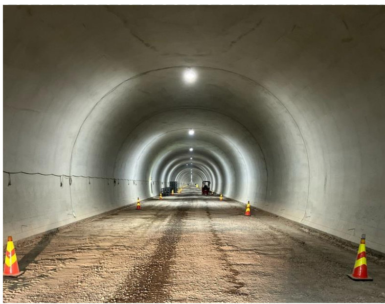
▲ トンネル坑内状況
