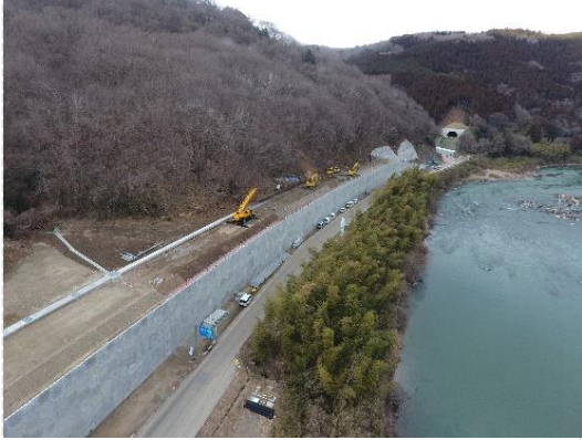
① 道路改良工事施工中
