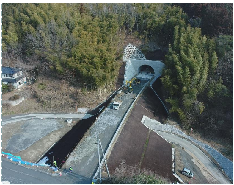
▲ 起点側(伊達市側)坑口全景
