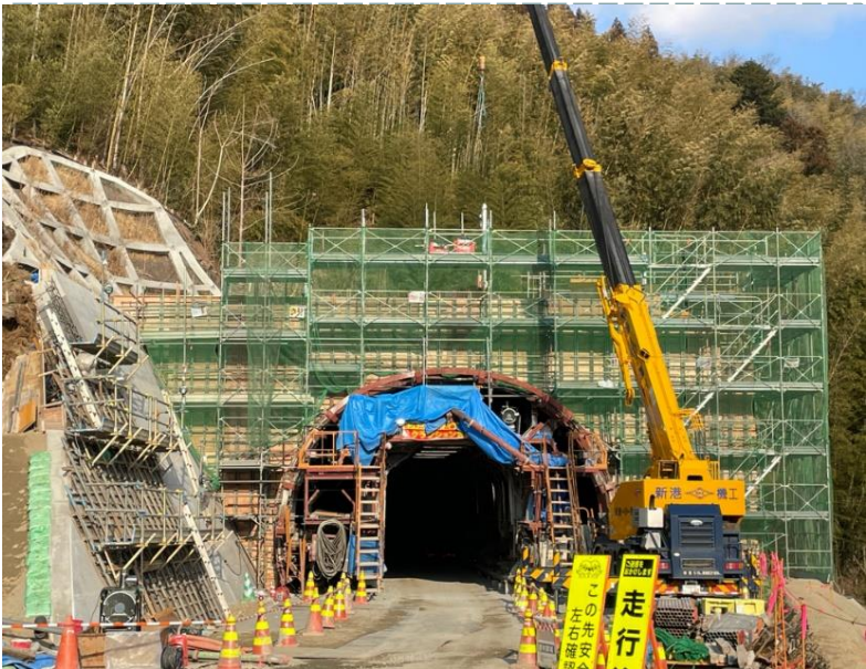
▲ 起点側(伊達市側)坑口全景
