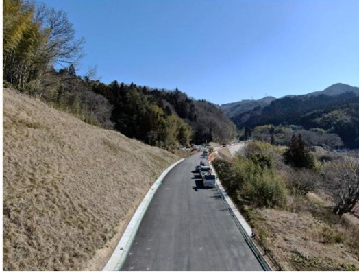
③ 舗装工事施工中
