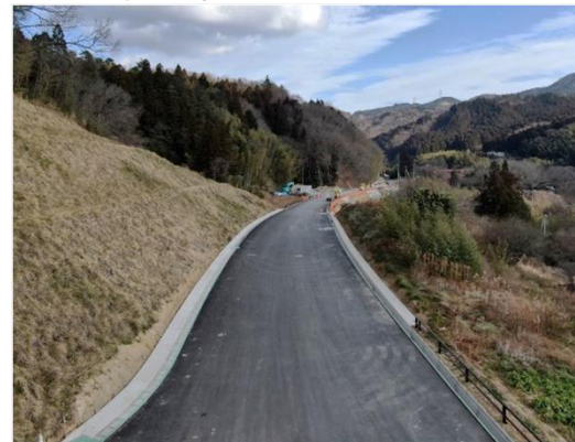
舗装工事施工中
