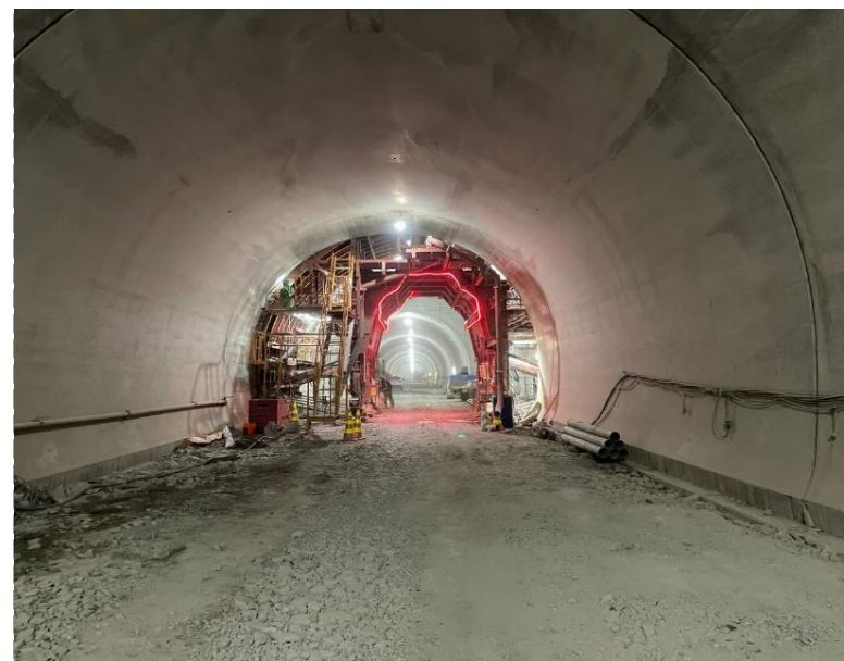
トンネル坑内状況
