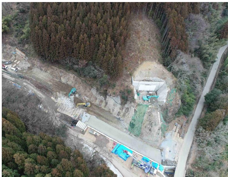
起点側(伊達市側)坑口全景
