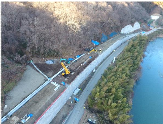
道路改良工事施工中
