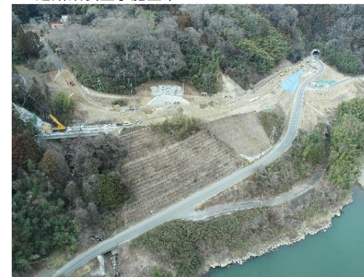
道路改良工事施工中
