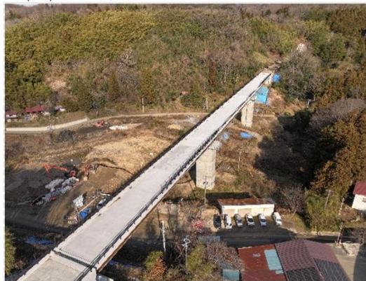
(仮)第1号橋 完成
