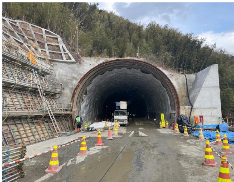
起点側(伊達市側)坑口全景
