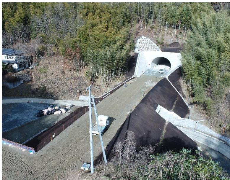
起点側(伊達市側)坑口全景
