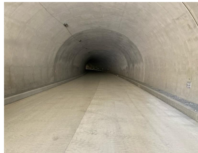
トンネル坑内状況
