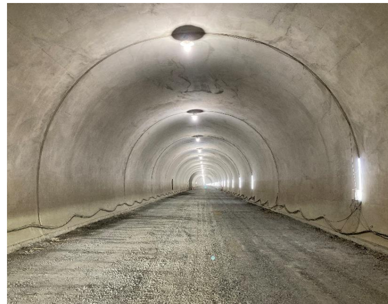
トンネル坑内状況
