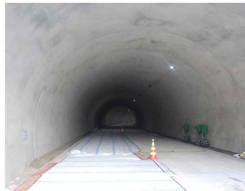
トンネル坑内状況
