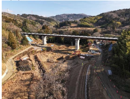
(仮)第1号橋 完成
