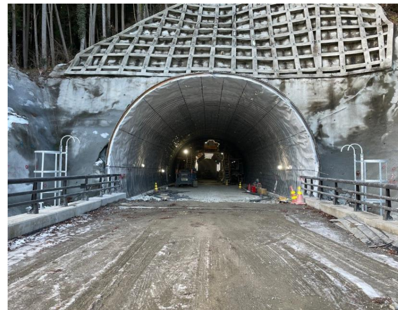
終点側(丸森町側)坑口全景
