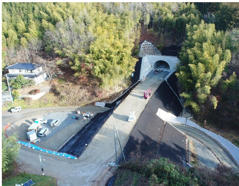
起点側(伊達市側)坑口全景
