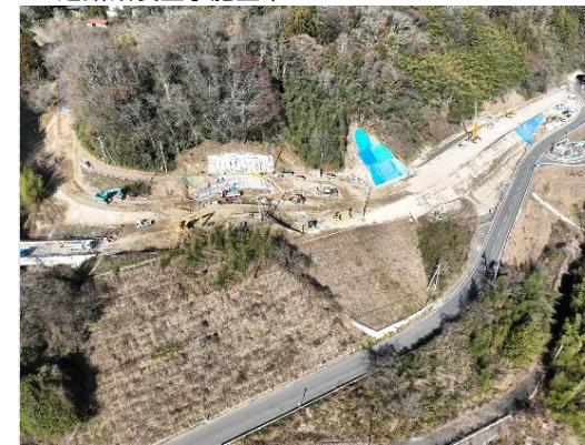
道路改良工事施工中
