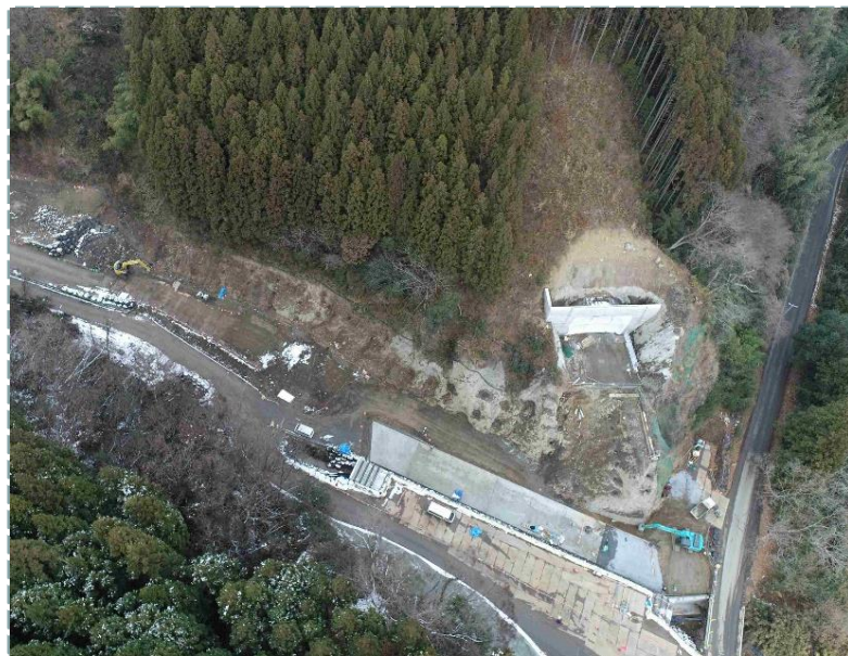
起点側(伊達市側)坑口全景
