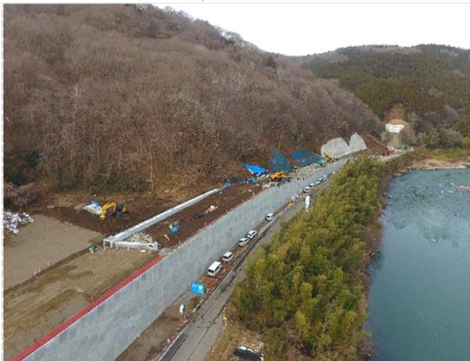
道路改良工事施工中
