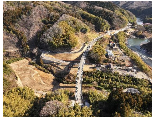
舗装工事施工中
