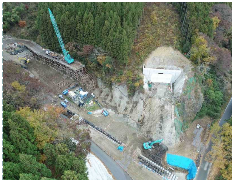
▲ 起点側(伊達市側)坑口全景
