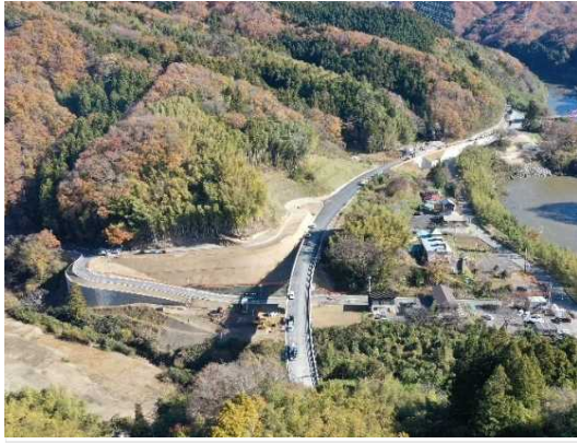
舗装工事施工中
