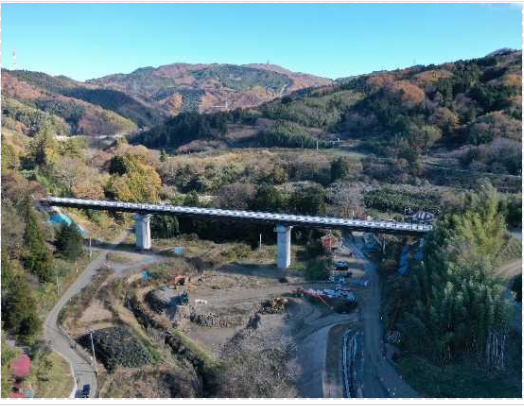
(仮)第1号橋 完成
