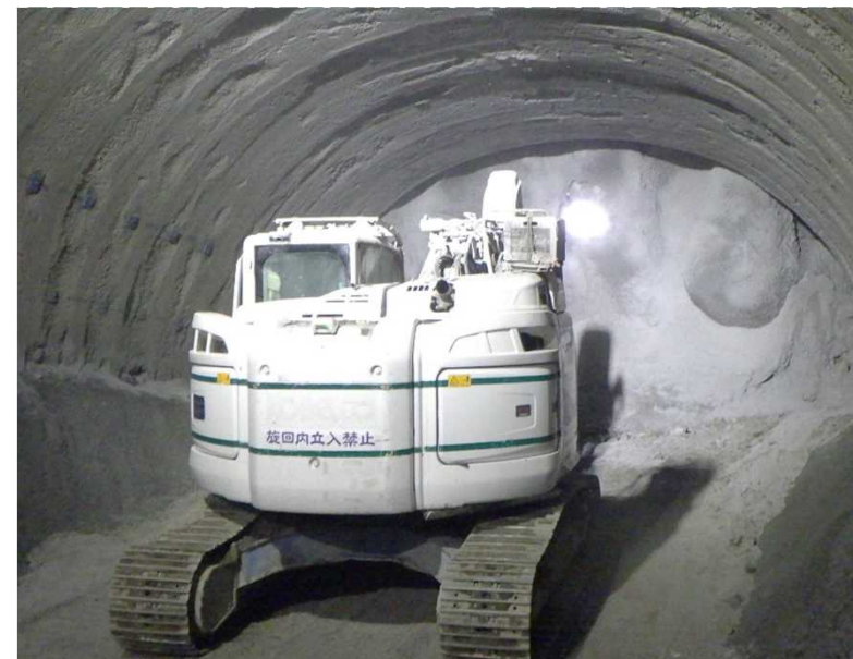
▲ トンネル貫通掘削
