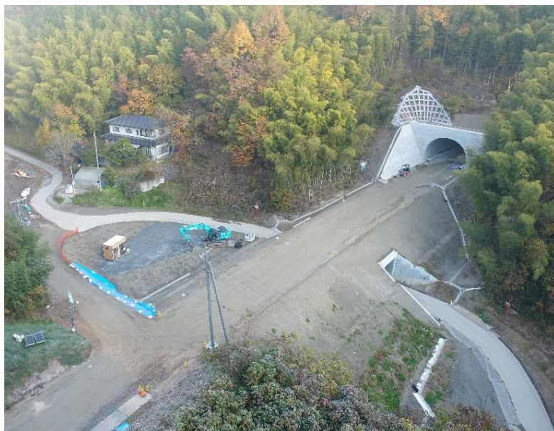
▲ 起点側(伊達市側)坑口全景
