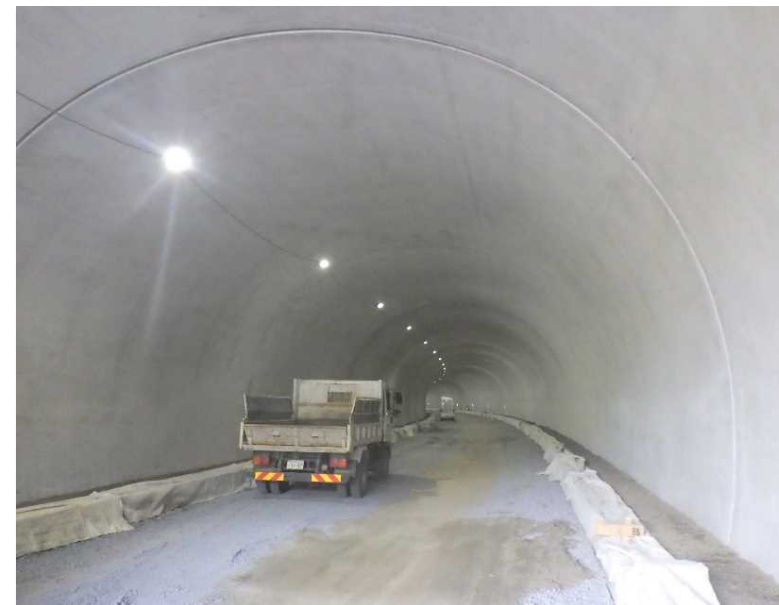
▲ トンネル坑内状況
