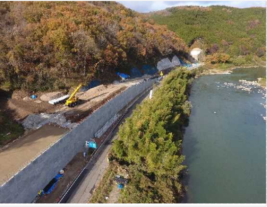
道路改良工事施工中
