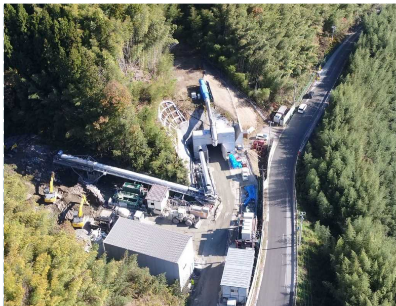
▲ 起点側(伊達市側)坑口全景
