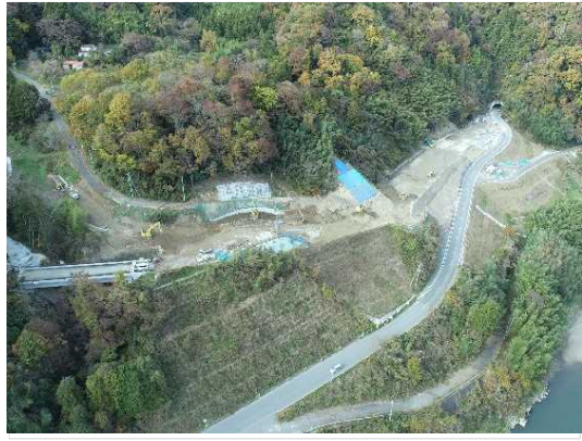
道路改良工事施工中
