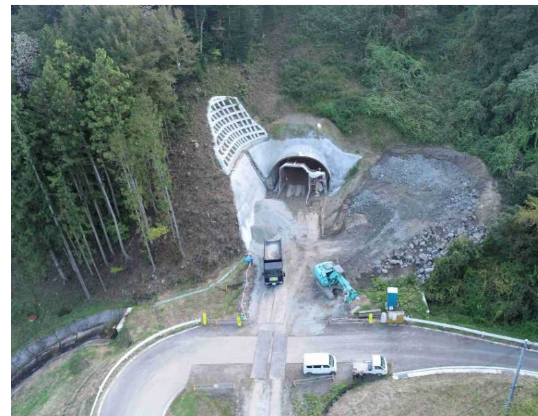
▲ 終点側(丸森町側)坑口全景
