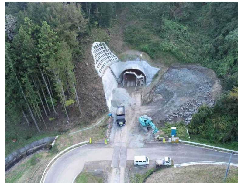
▲ 終点側(丸森町側)坑口全景
