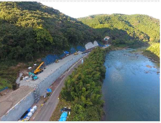
道路改良工事施工中
