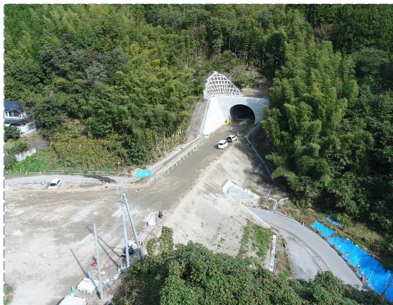
▲ 起点側(伊達市側)坑口全景
