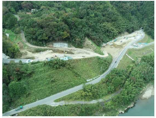
道路改良工事施工中
