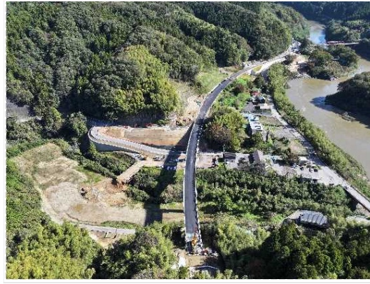
舗装工事施工中
