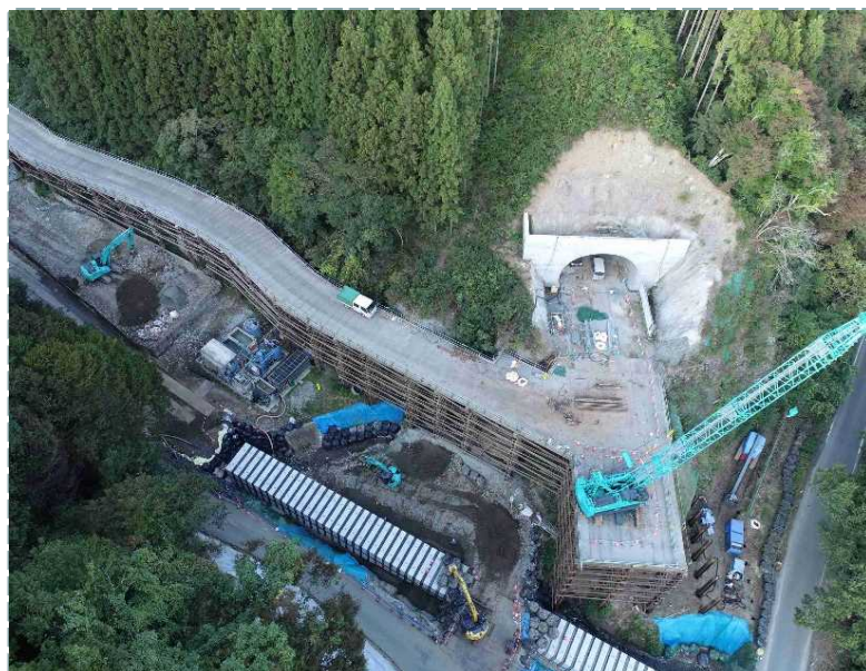
▲ 起点側(伊達市側)坑口全景
