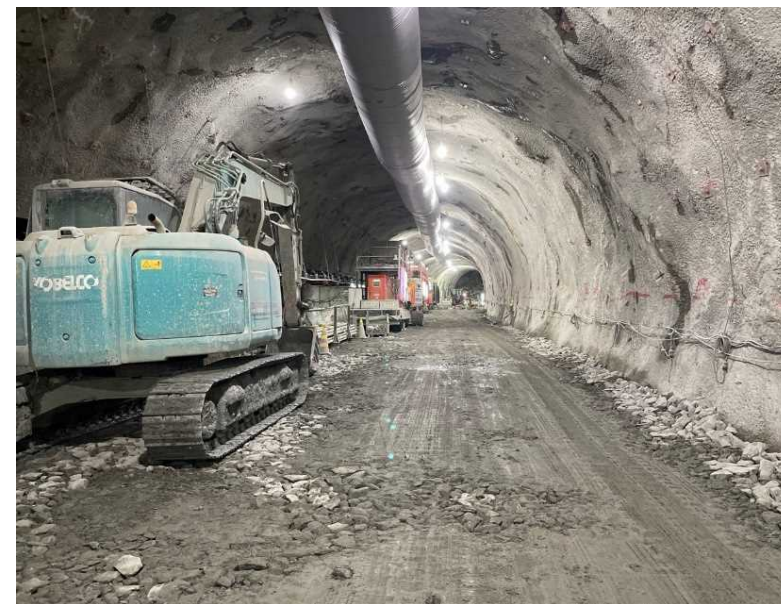
▲ トンネル坑内状況
