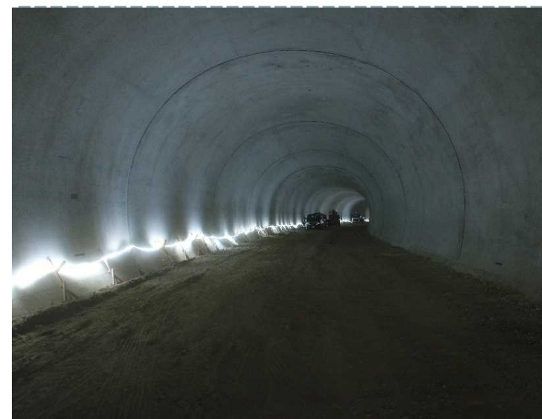
▲ トンネル坑内状況
