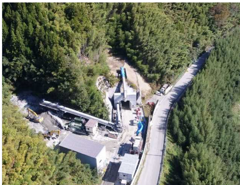
▲ 起点側(伊達市側)坑口全景
