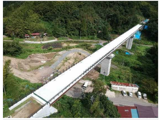
(仮)第1号橋 完成
