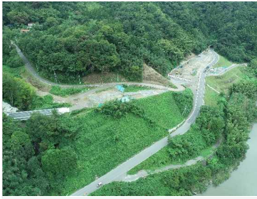
道路改良工事施工中
