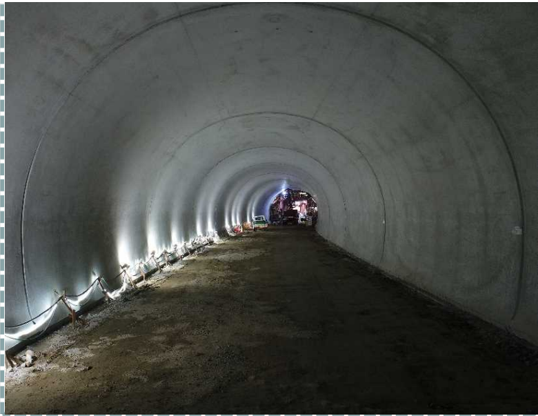
▲ トンネル坑内状況
