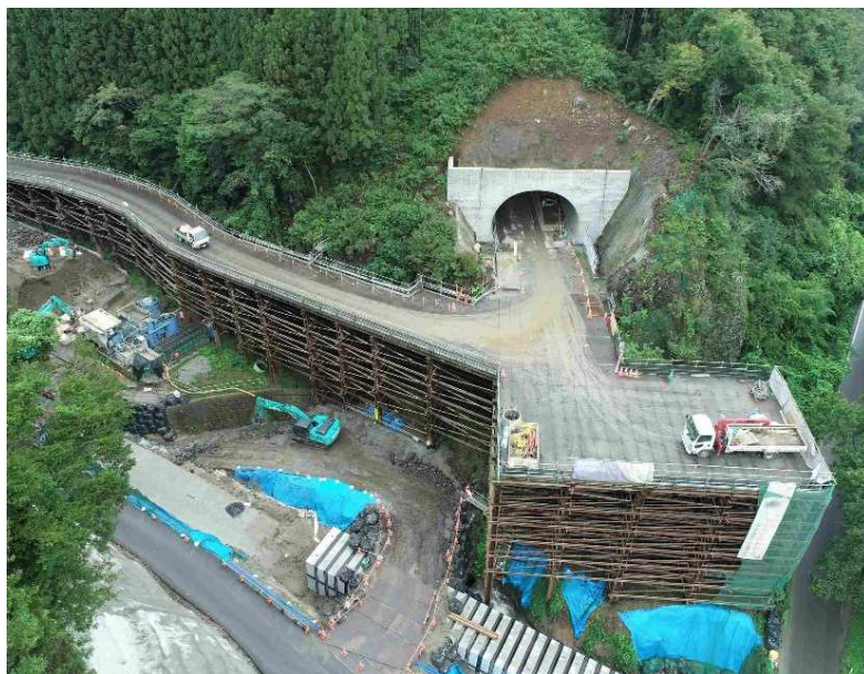
▲ 起点側(伊達市側)坑口全景
