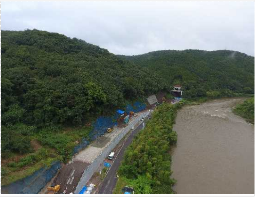
道路改良工事施工中
