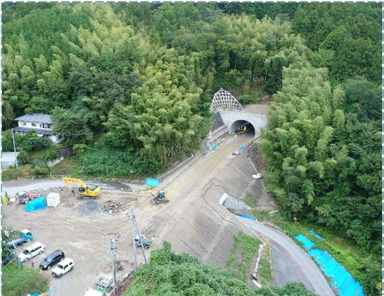
▲ 起点側(伊達市側)坑口全景
