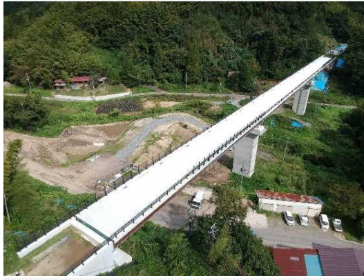
(仮)第1号橋完成
