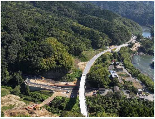
舗装工事施工中
