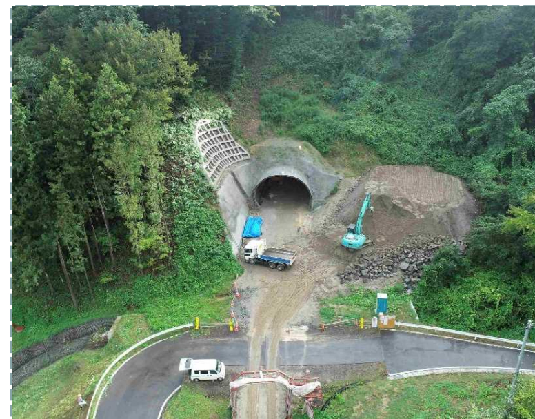
▲ 終点側(丸森町側)坑口全景
