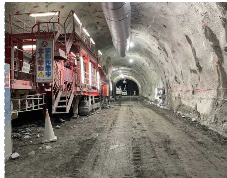
▲ トンネル坑内状況
