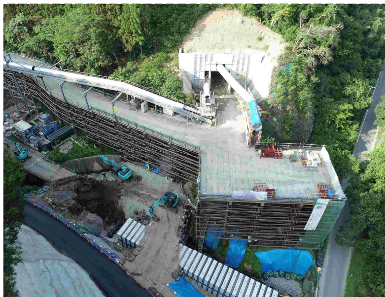
▲ 起点側(伊達市側)坑口全景
