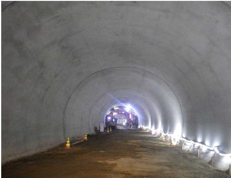
▲ トンネル坑内状況
