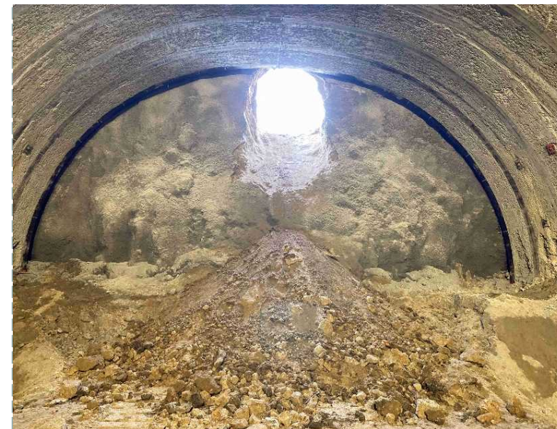
▲ トンネル貫通掘削
