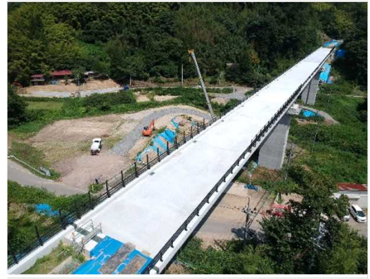
(仮)第1号橋完成
