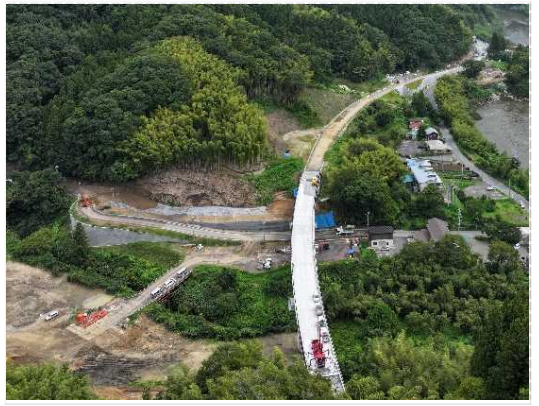
舗装工事施工中
