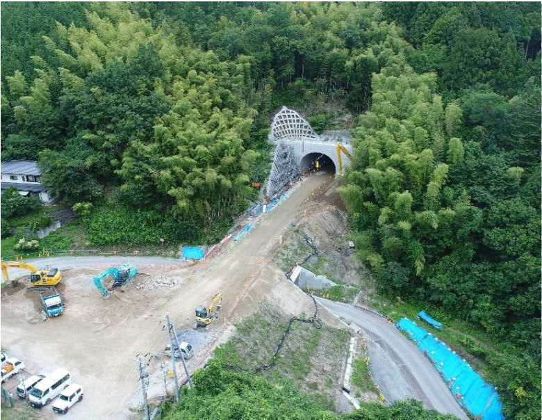
▲ 起点側(伊達市側)坑口全景
