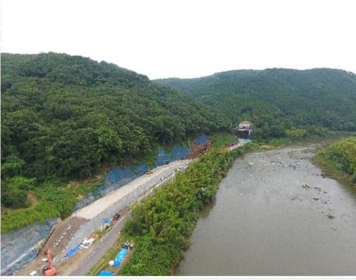
道路改良工事施工中
