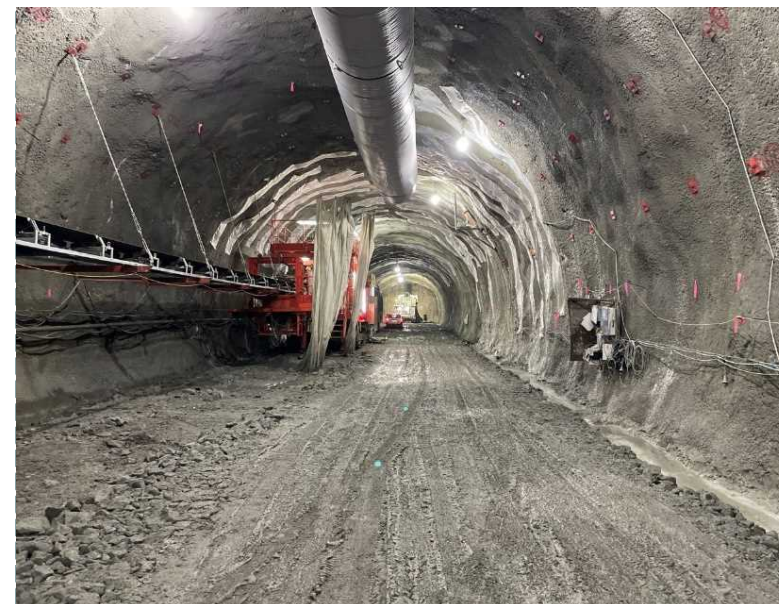
▲ トンネル坑内状況
