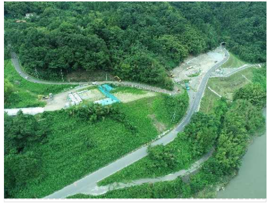
道路改良工事施工中
