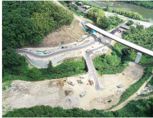
道路改良工事施工中
