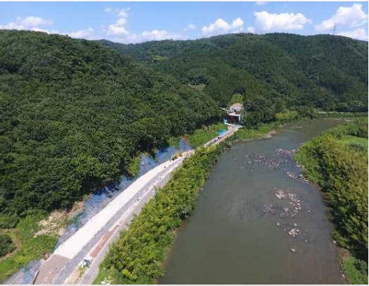
道路改良工事施工中
