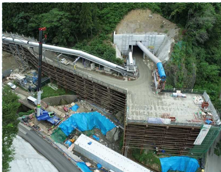
▲ 起点側(伊達市側)坑口全景
