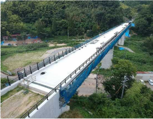
(仮)第1号橋完成
