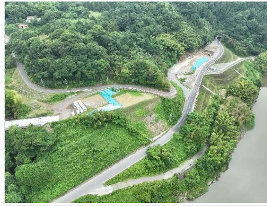
道路改良工事施工中
