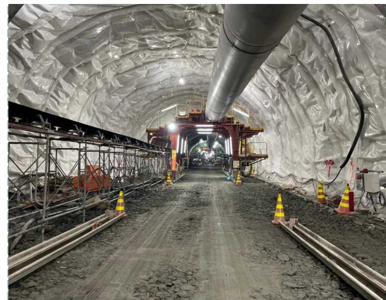
▲ トンネル坑内状況
