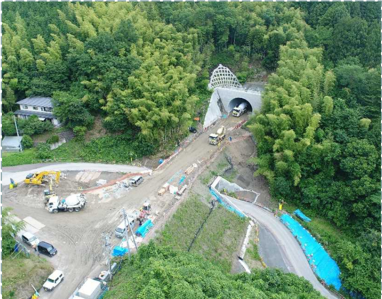
▲ 起点側(伊達市側)坑口全景
