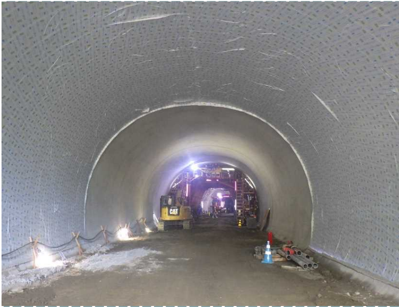
▲ トンネル坑内状況
