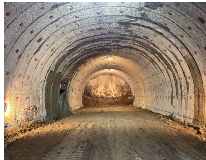
▲ トンネル坑内状況
