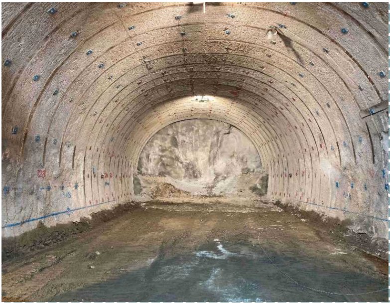
▲ トンネル坑内状況
