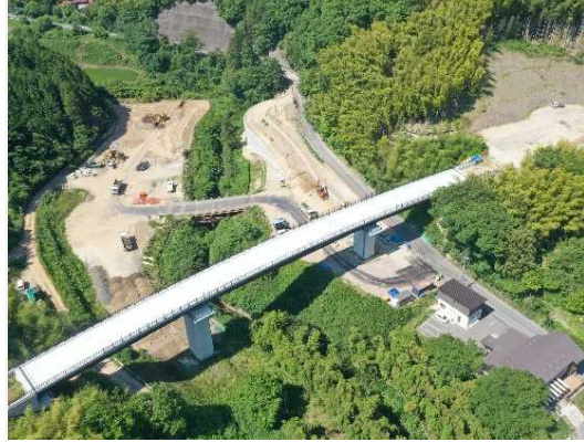
③ 舗装工事施工中
