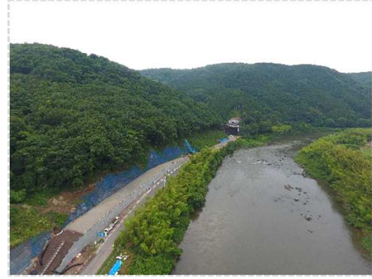
① 道路改良工事施工中
