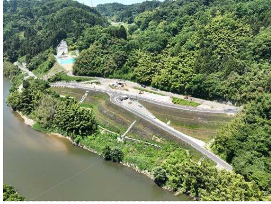
④ 道路改良工事施工中
