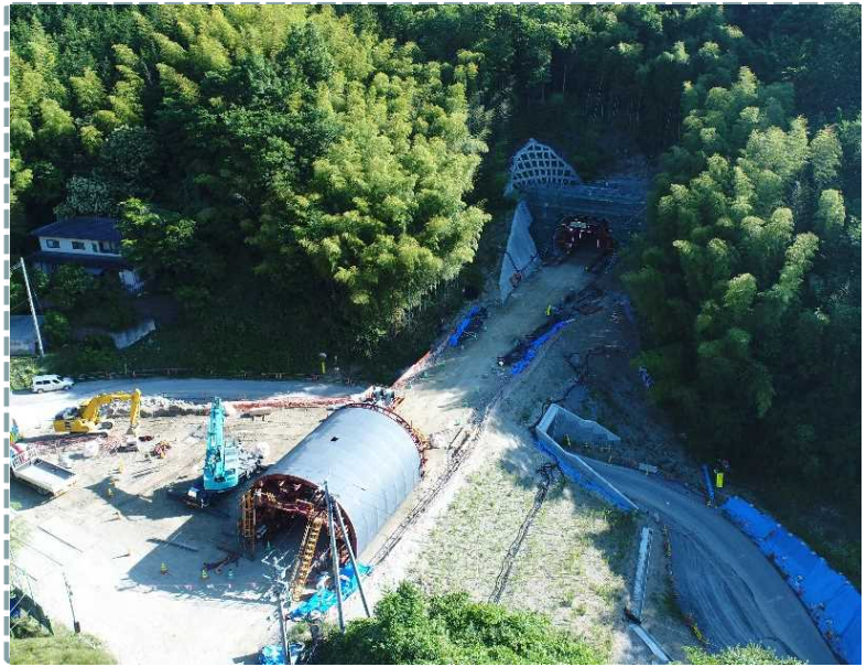
▲ 起点側(伊達市側)坑口全景
