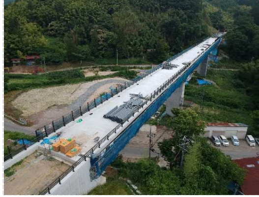
② 床版工工事施工中
