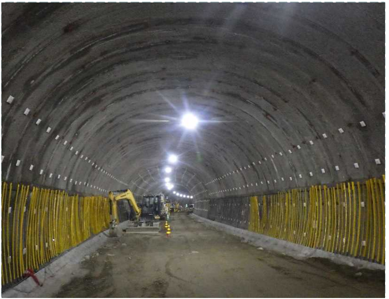
▲ トンネル坑内状況
