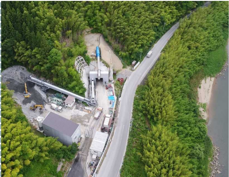
▲ 起点側(伊達市側)坑口全景
