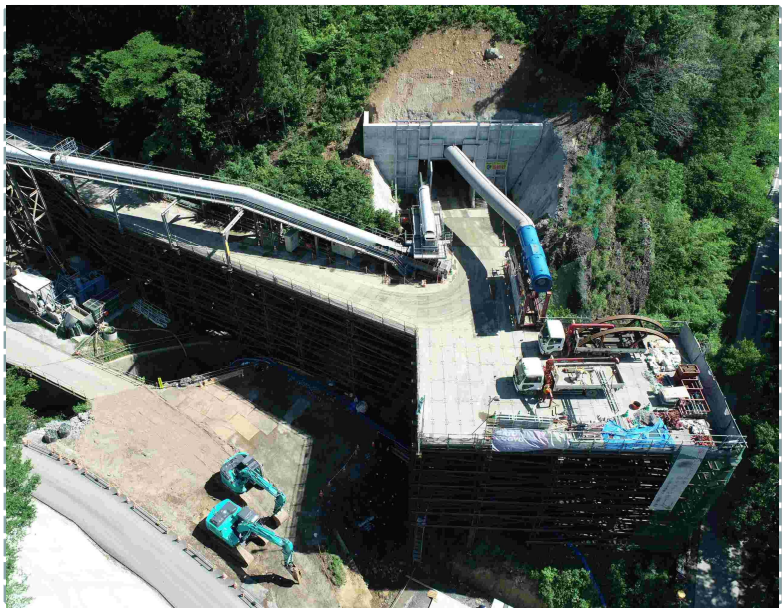
▲ 起点側(伊達市側)坑口全景
