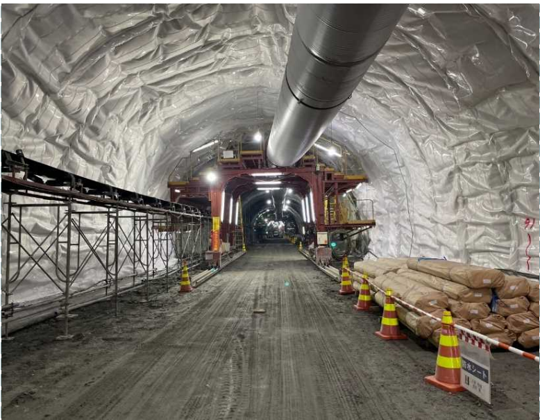
▲ トンネル坑内状況
