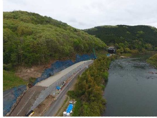
① 道路改良工事施工中
