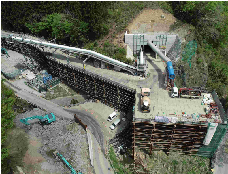
▲ 起点側(伊達市側)坑口全景
