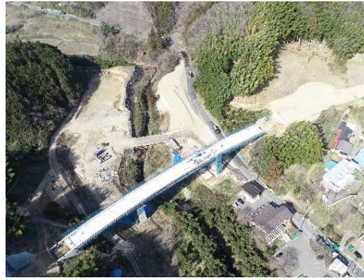
③ 舗装工事施工中
