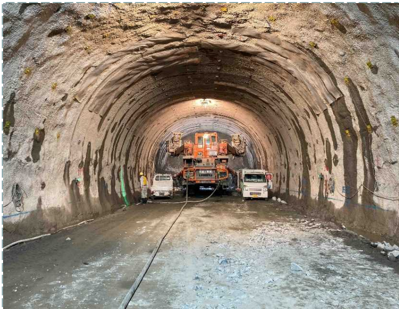
▲ トンネル坑内状況
