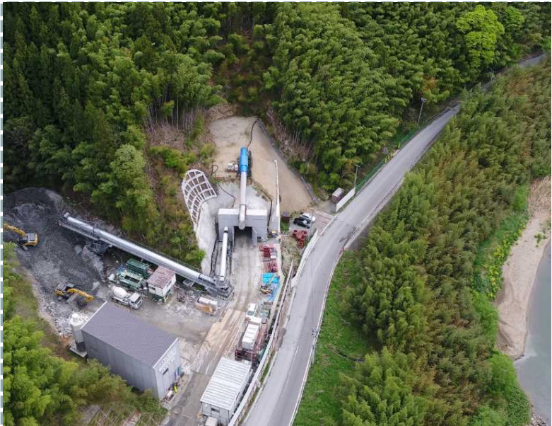
▲ 起点側(伊達市側)坑口全景
