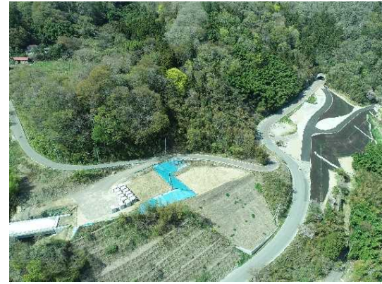
④ 道路改良工事施工中
