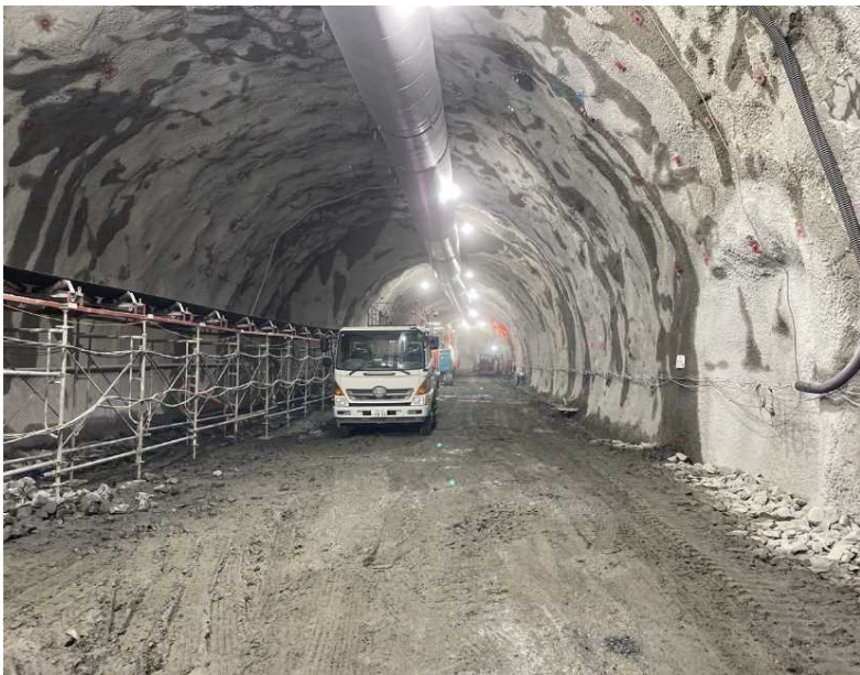
▲ トンネル坑内状況
