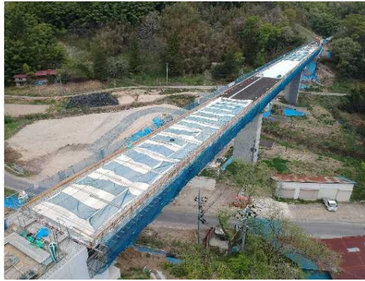
② 床版工工事施工中
