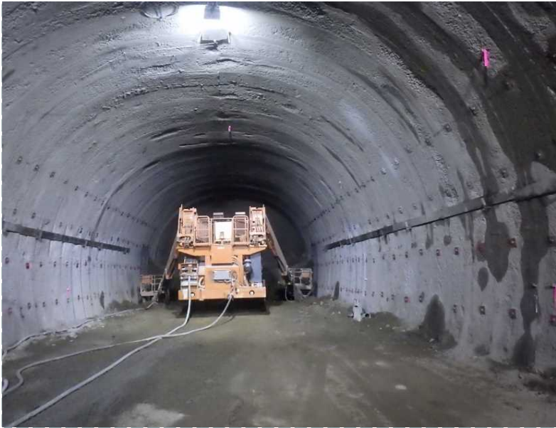
▲ トンネル坑内状況
