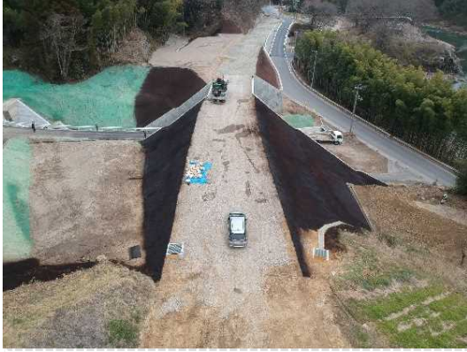
③ 道路改良工事施工中
