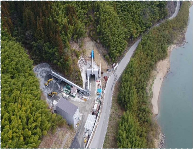
▲ 起点側(伊達市側)坑口全景
