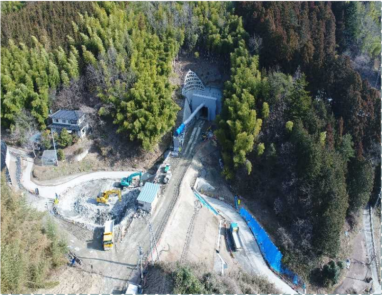
▲ 起点側(伊達市側)坑口全景
