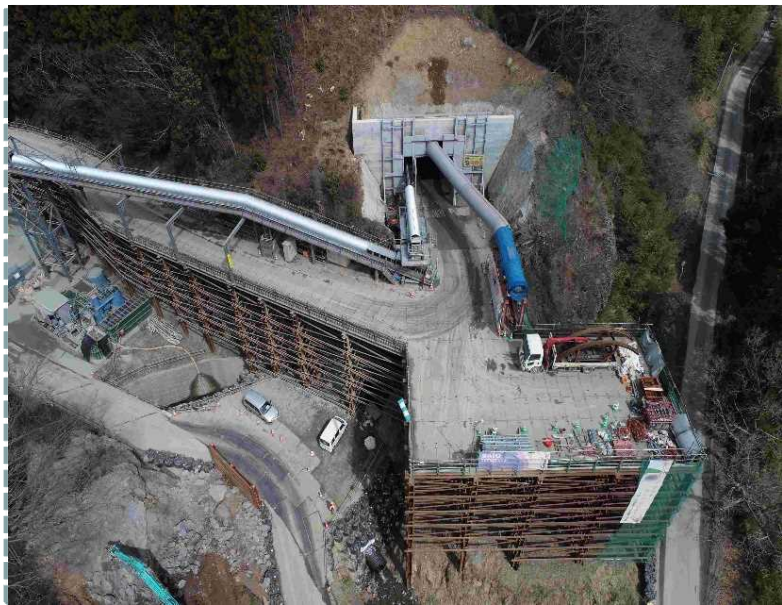
▲ 起点側(伊達市側)坑口全景
