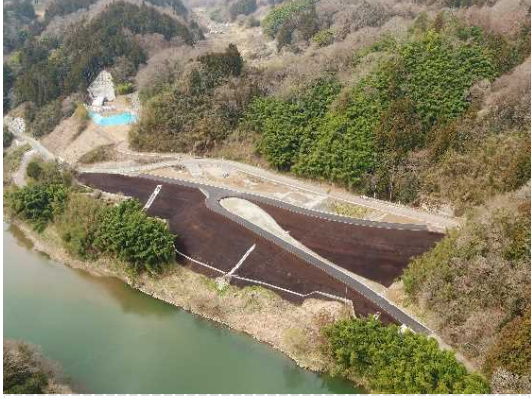
④ 道路改良工事施工中
