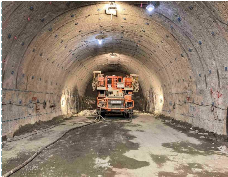
▲ トンネル坑内状況
