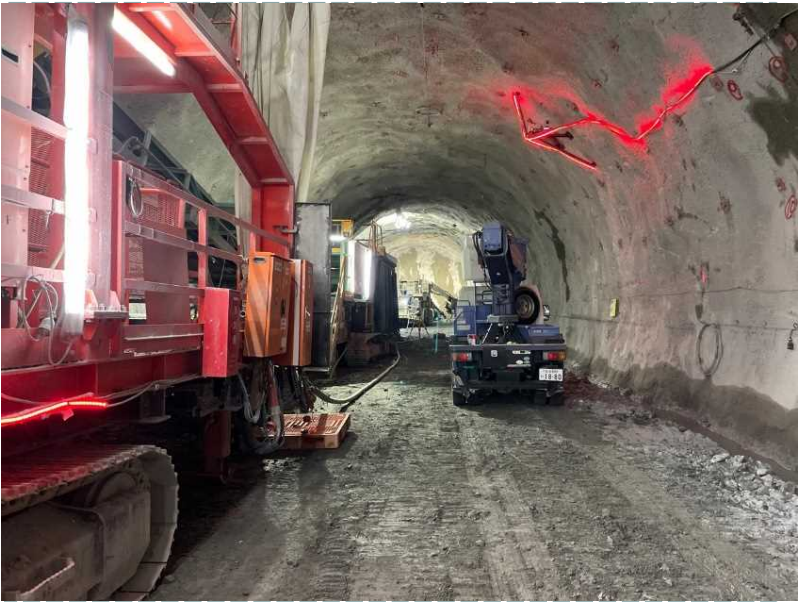
▲ トンネル坑内状況
