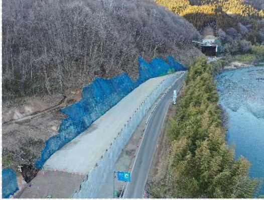
① 道路改良工事施工中
