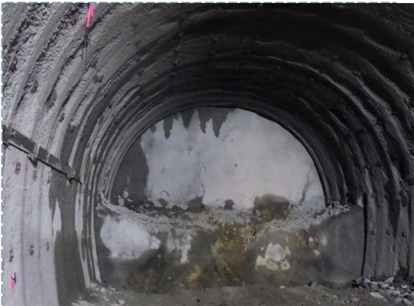
▲ トンネル坑内状況
