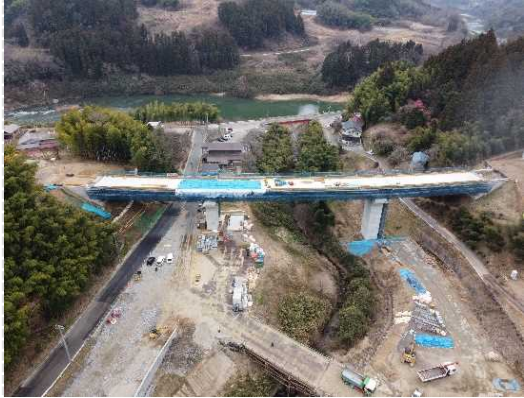
② 床版工工事施工中
