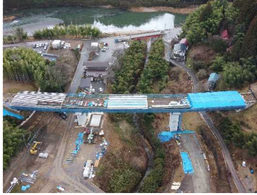
② 床版工工事施工中
