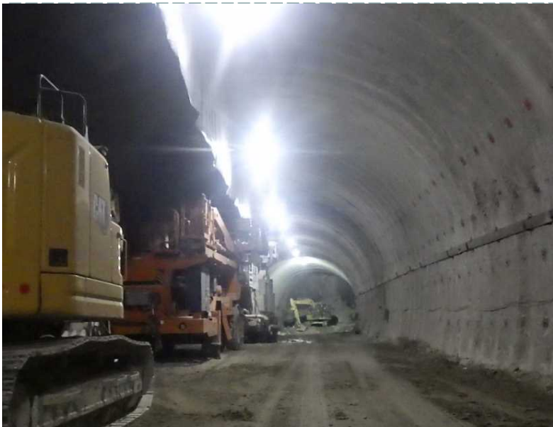
▲ トンネル坑内状況
