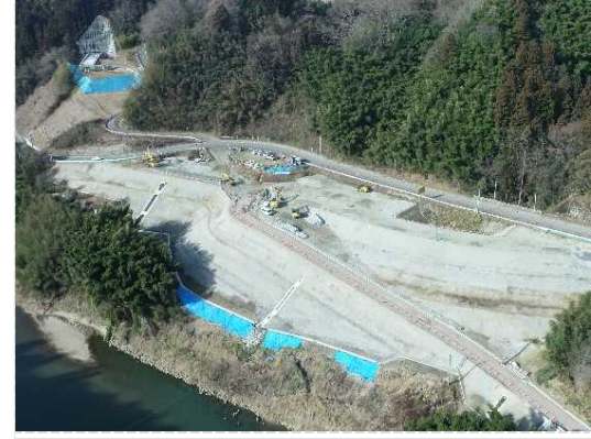
④ 道路改良工事施工中
