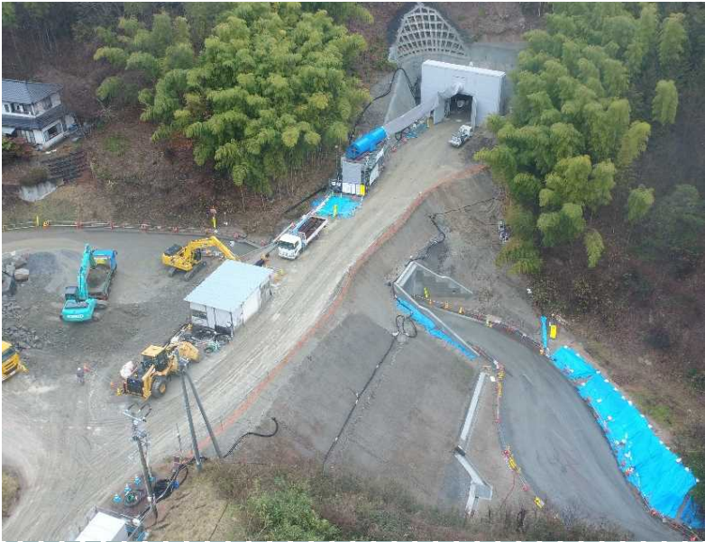
▲ 起点側(伊達市側)坑口全景
