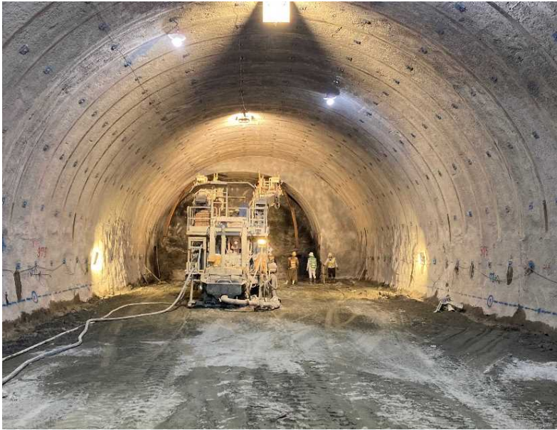
▲ トンネル坑内状況
