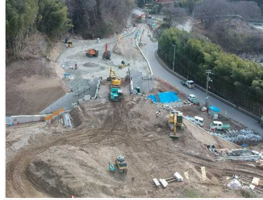
③ 道路改良工事施工中
