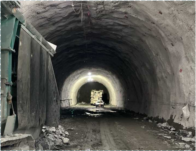
▲ トンネル坑内状況
