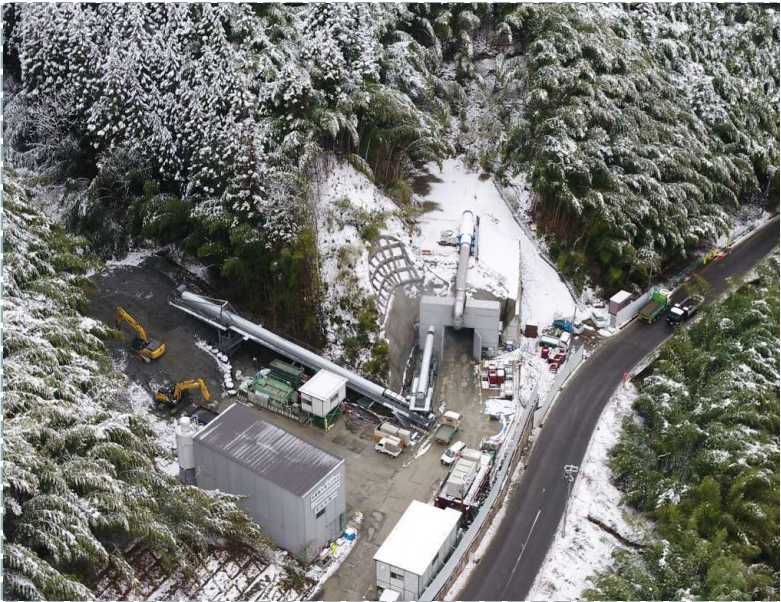
▲ 起点側(伊達市側)坑口全景
