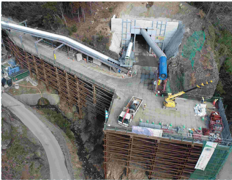
▲ 起点側(伊達市側)坑口全景
