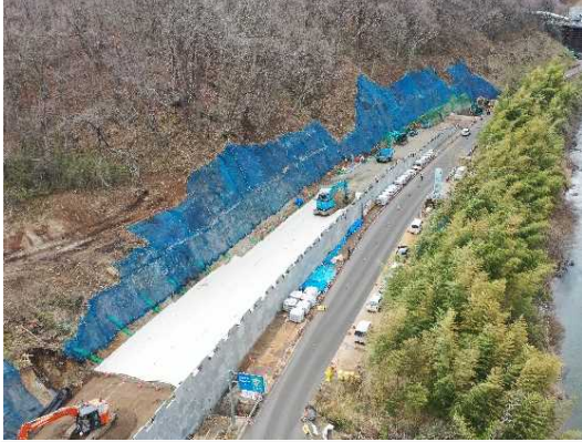
① 道路改良工事施工中
