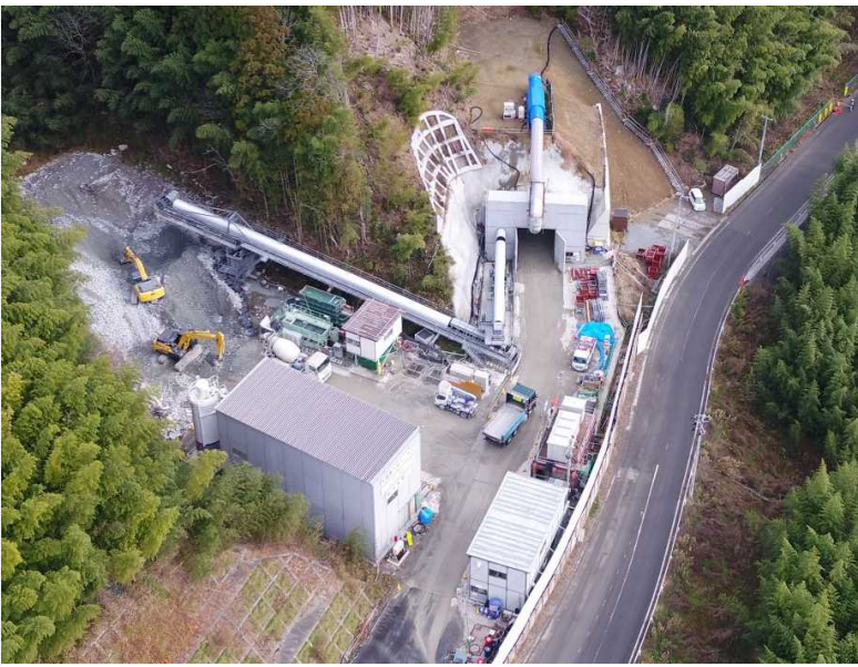
▲ 起点側(伊達市側)坑口全景
