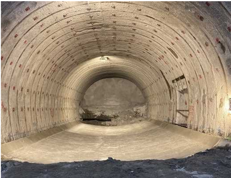
▲ トンネル坑内状況
