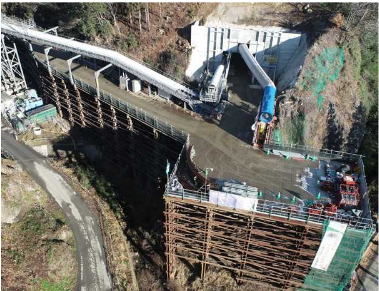
▲ 起点側(伊達市側)坑口全景
