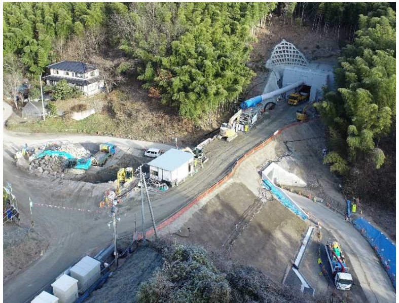
▲ 起点側(伊達市側)坑口全景
