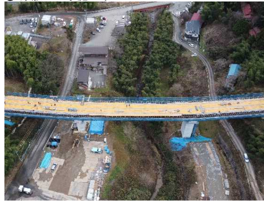
② 床版工工事施工中
