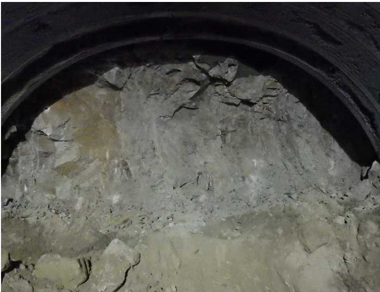
▲ トンネル坑内状況
