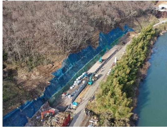
① 道路改良工事施工中
