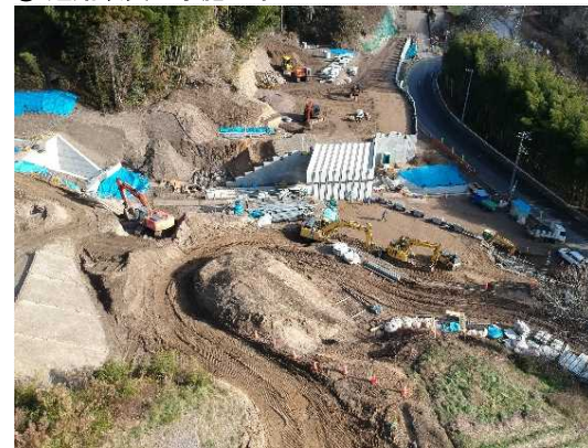
③ 道路改良工事施工中
