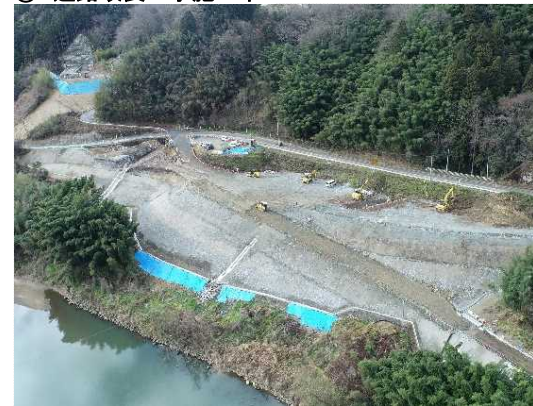
④ 道路改良工事施工中
