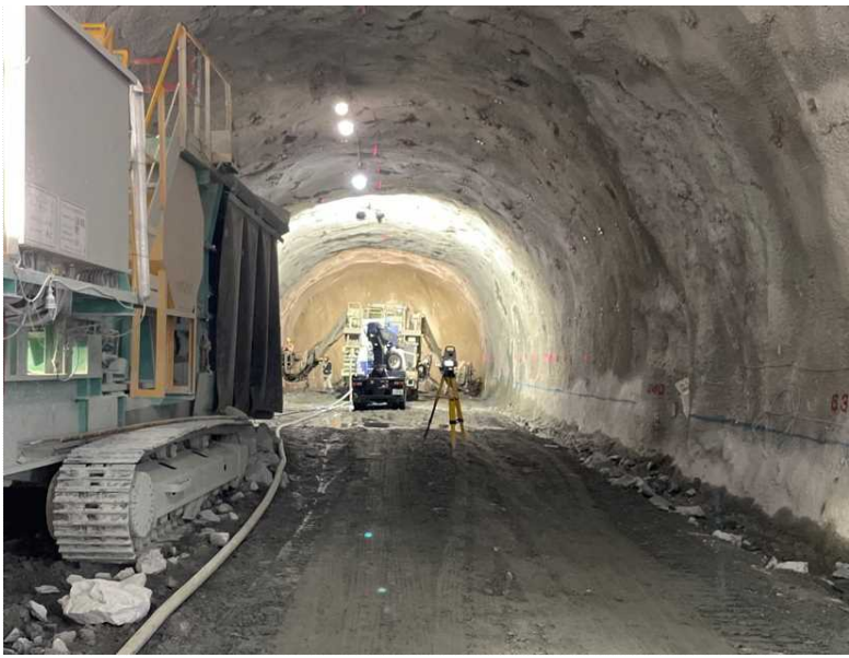
▲ トンネル坑内状況
