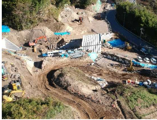
③ 道路改良工事施工中
