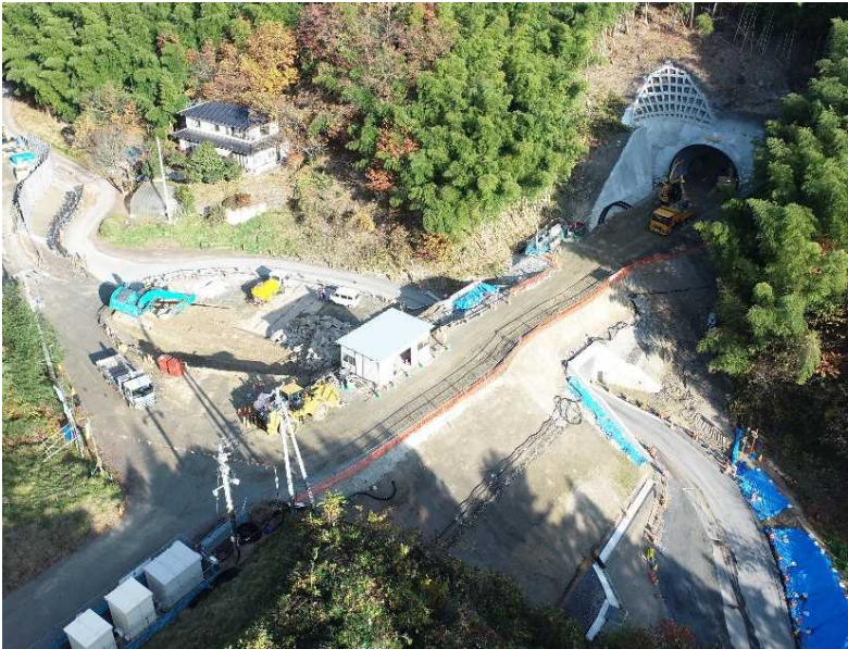
▲ 起点側(伊達市側)坑口全景
