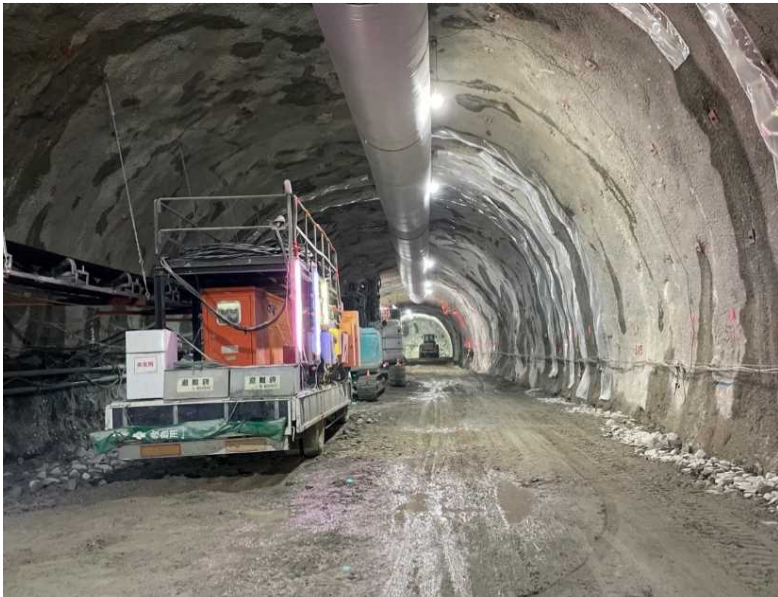
▲ トンネル坑内状況
