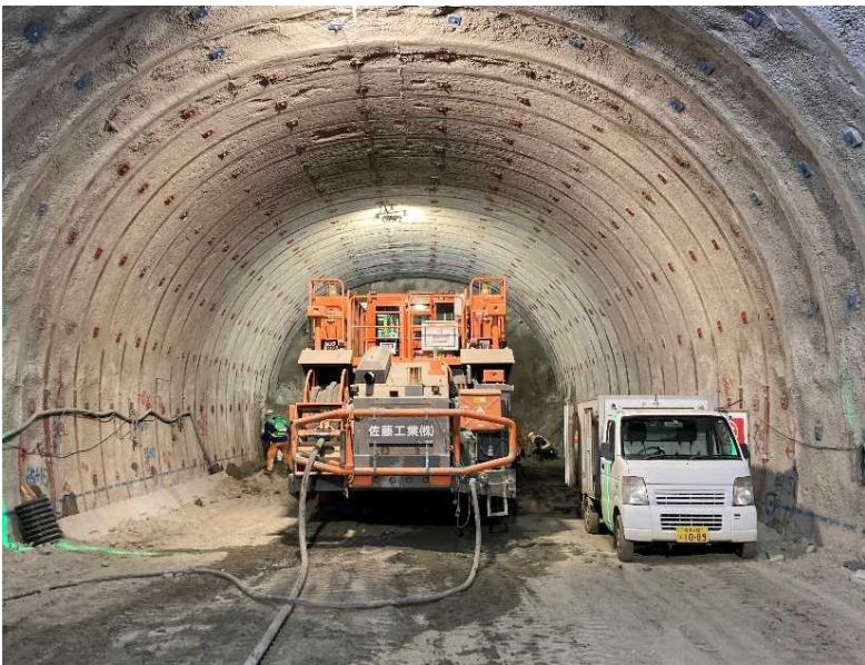
▲ トンネル坑内状況
