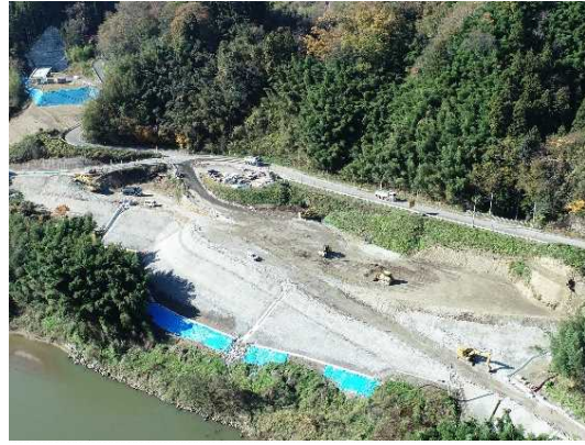
④ 道路改良工事施工中
