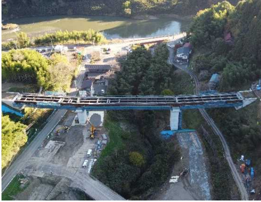
② 床版工工事施工中
