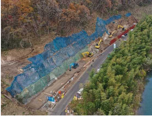
① 道路改良工事施工中
