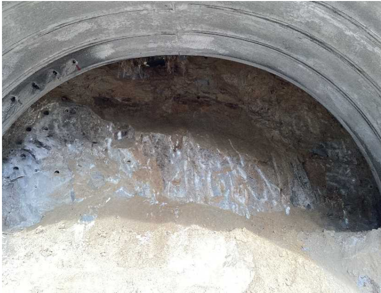
▲ トンネル坑内状況
