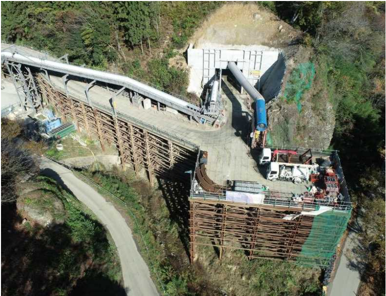
▲ 起点側(伊達市側)坑口全景
