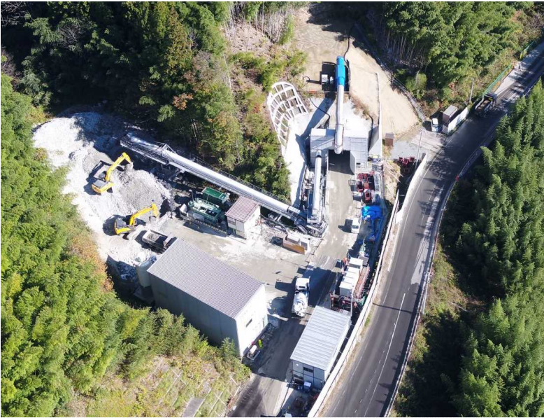
▲ 起点側(伊達市側)坑口全景
