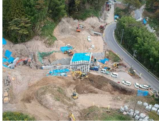
③ 道路改良工事施工中
