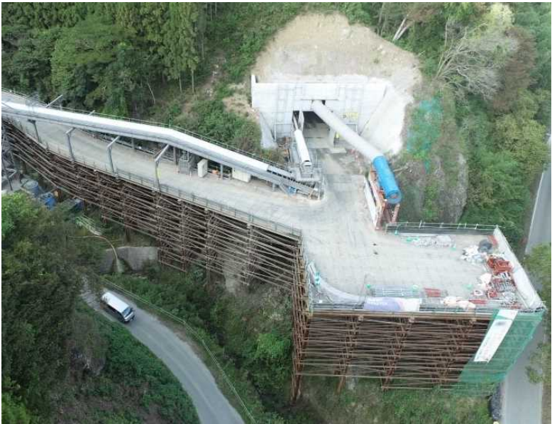
▲ 起点側(伊達市側)坑口全景
