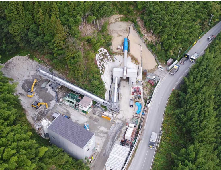
▲ 起点側(伊達市側)坑口全景
