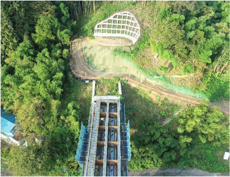
▲ 終点側(丸森町側)坑口全景
