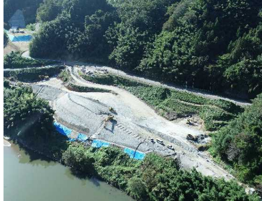
④ 道路改良工事施工中
