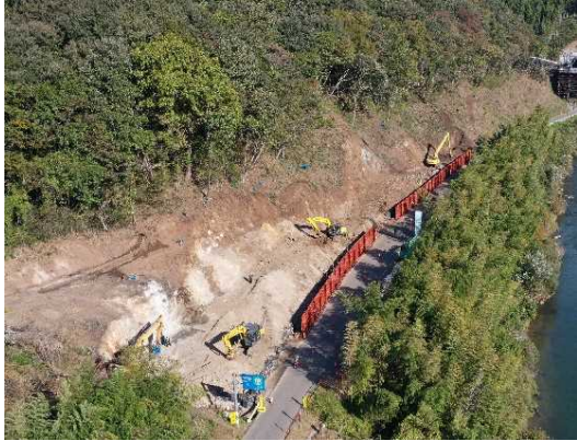
① 道路改良工事施工中
