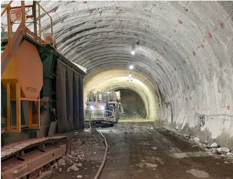
▲ トンネル坑内状況
