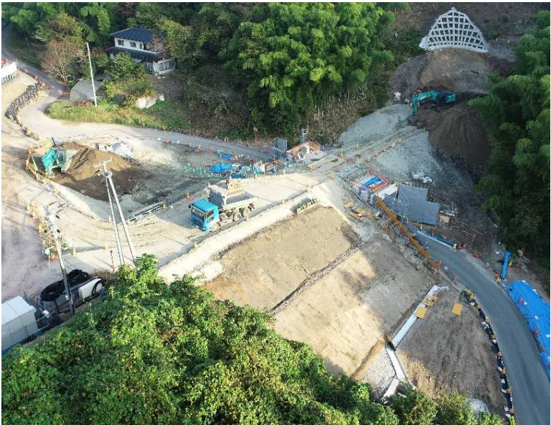
▲ 起点側(伊達市側)坑口全景
