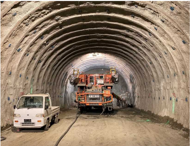
▲ トンネル坑内状況
