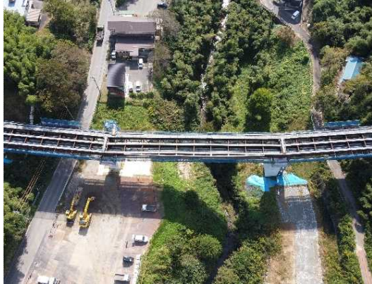
② 床版工事施工中
