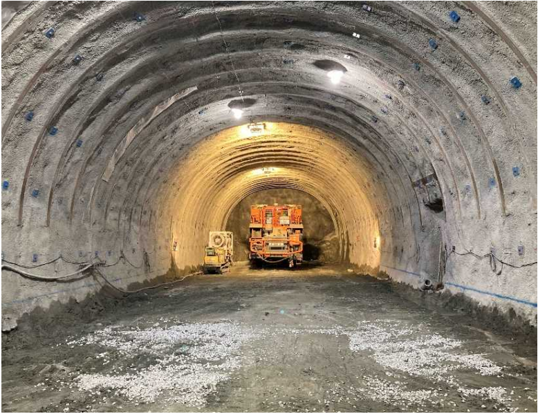
▲ トンネル坑内状況
