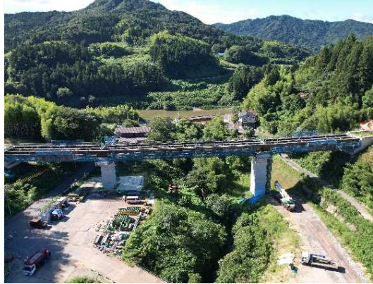
② 上部工工事施工中
