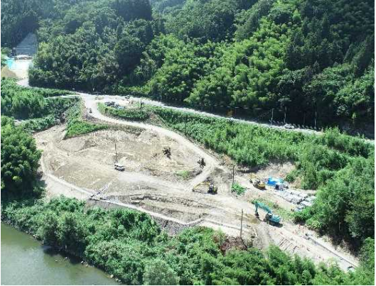
④ 道路改良工事施工中
