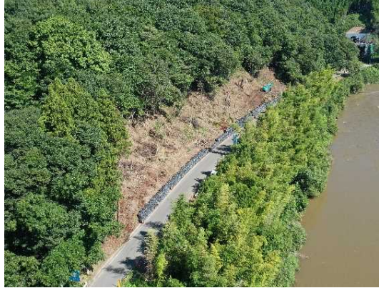
① 道路改良工事施工中
