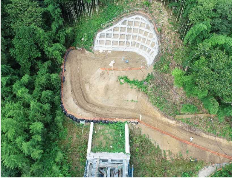
▲ 終点側(丸森町側)坑口全景
