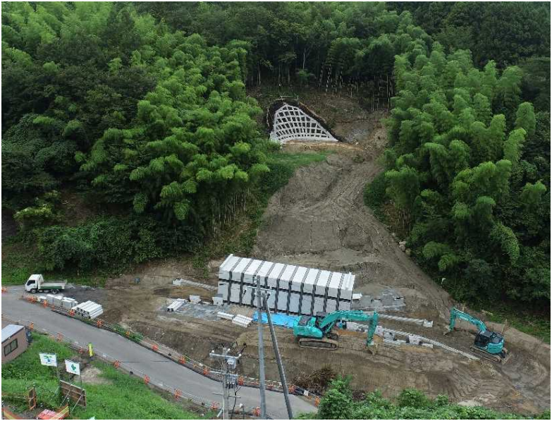
▲ 起点側(伊達市側)坑口全景
