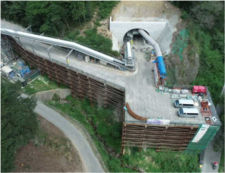
▲ 起点側(伊達市側)坑口全景
