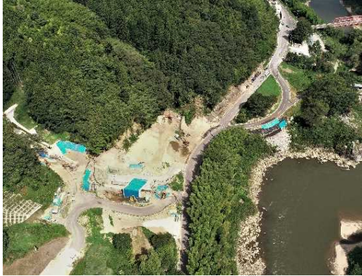
③ 道路改良工事施工中
