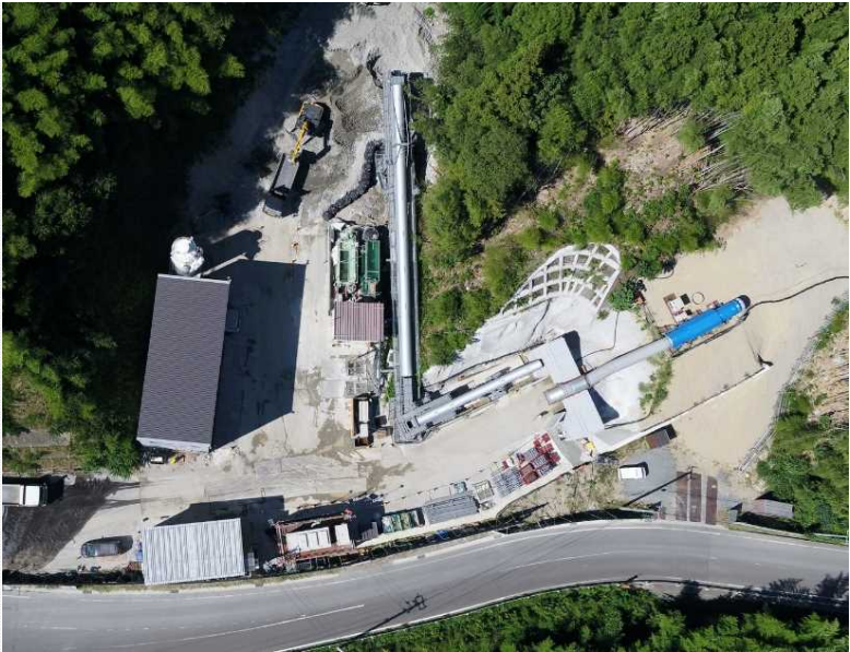
▲ 起点側(伊達市側)坑口全景
