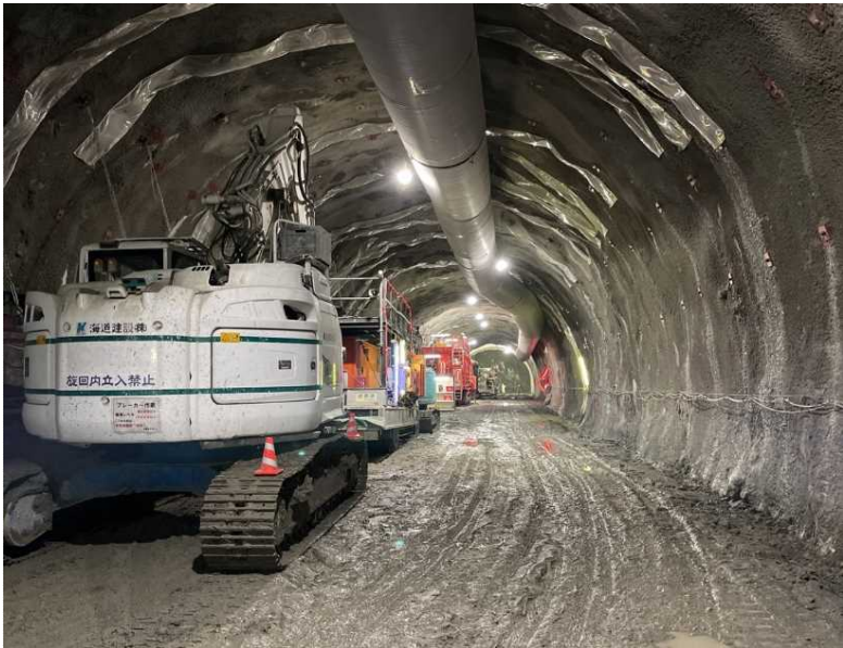
▲ トンネル坑内状況
