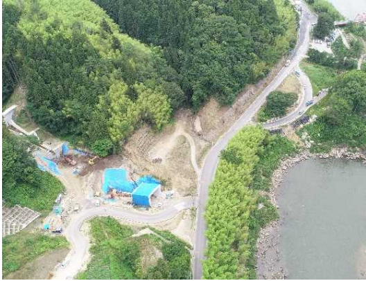
③ 道路改良工事施工中
