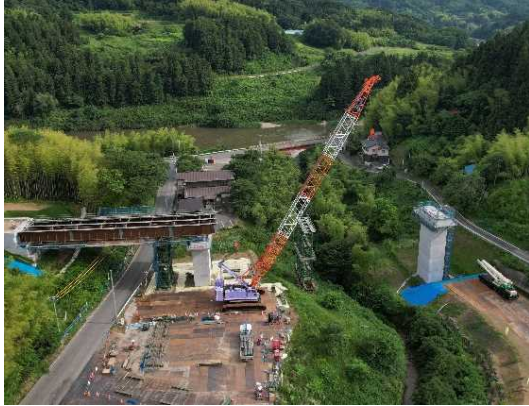
② 上部工施工中
