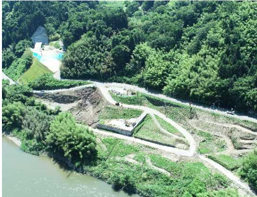
④ 道路改良工事施工中
