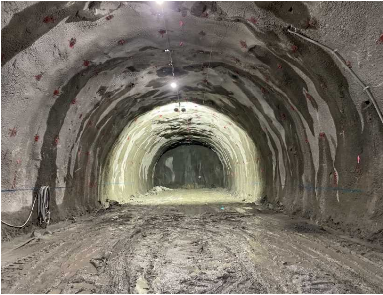
▲トンネル坑内状況
