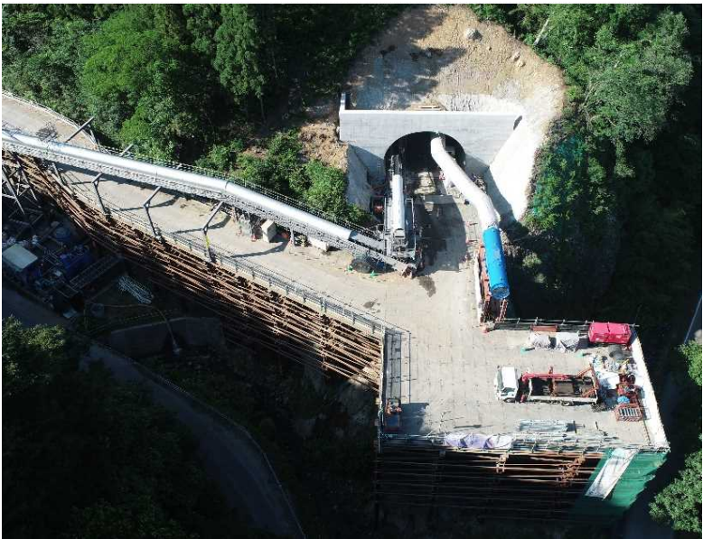
▲ 起点側(伊達市側)坑口全景
