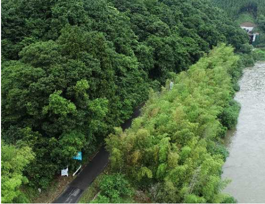
① 道路改良工事施工中
