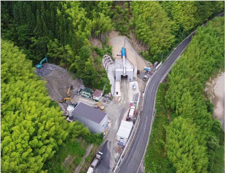
▲起点側(伊達市側)坑口全景
