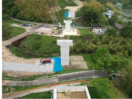
② 上部工施工中
