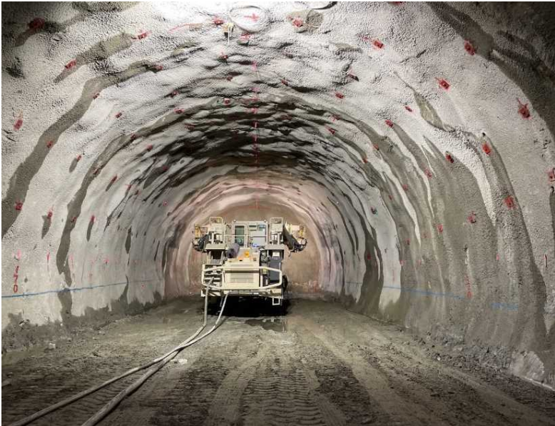
▲トンネル坑内状況
