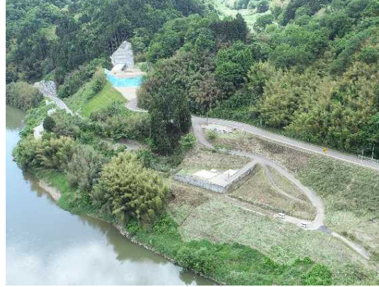
④ 道路改良工事施工中
