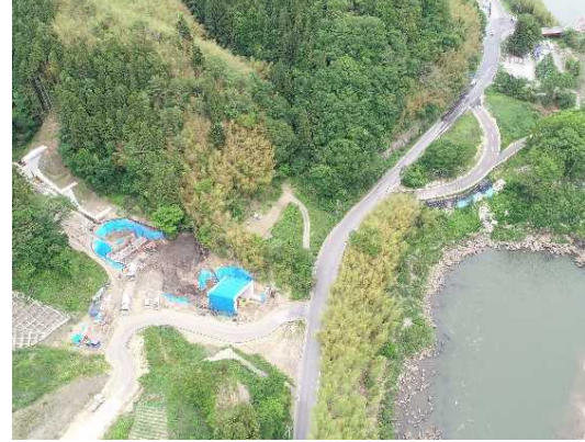
③ 道路改良工事施工中
