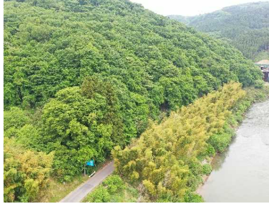
① 道路改良工事施工中
