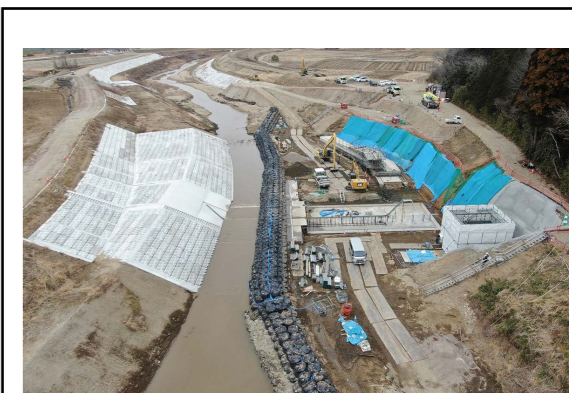
山下堰施工状況写真
