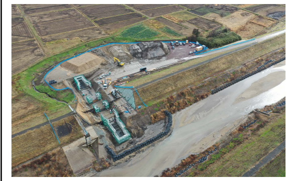
中平西樋門施工状況写真
