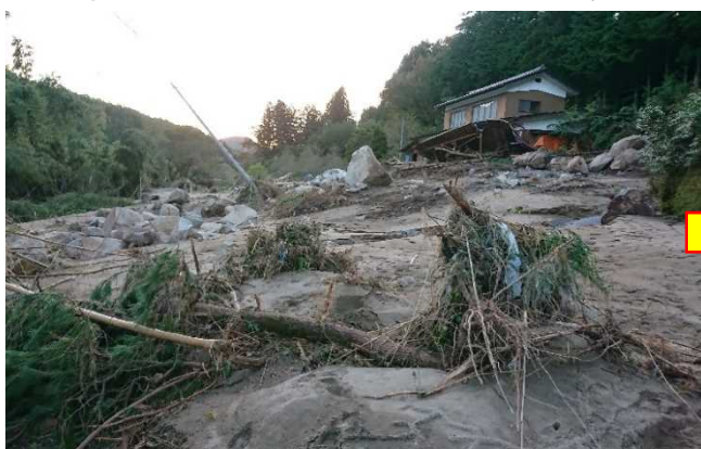
写真④:被災状況(令和元年10月15日撮影)
