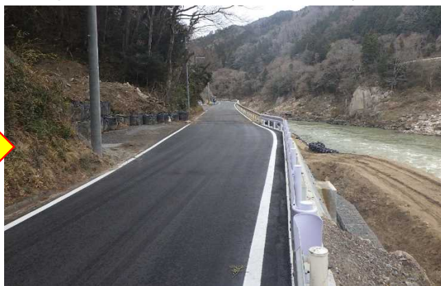
写真③:復旧状況(令和3年3月16日撮影)
