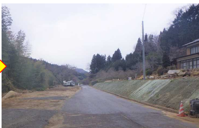
写真④:復旧状況(令和3年3月16日撮影)
