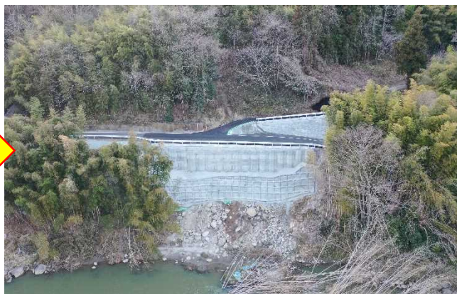
写真⑤:復旧状況(令和3年3月16日撮影)
