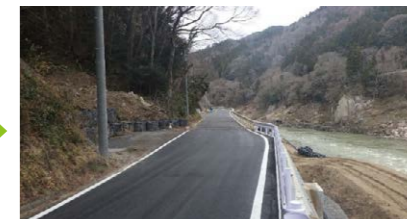
令和3年3月24日 本復旧完了
