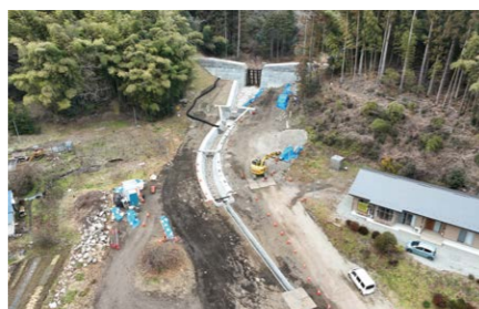
▲新設工事（大畑沢砂防堰堤）
