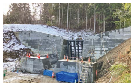
▲新設工事（川下三砂防堰堤）
