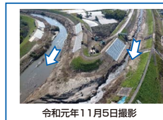
応急復旧完了後の状況
