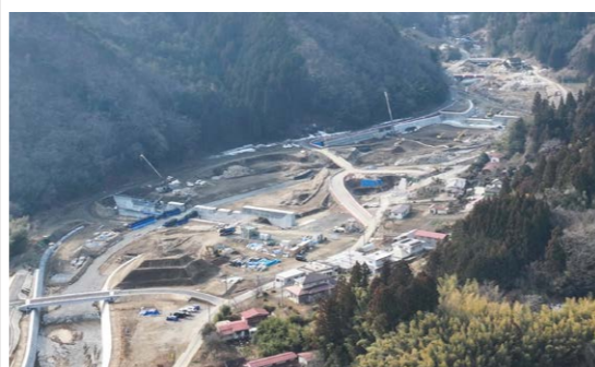
▲遊砂地工事（五福谷川遊砂地）
