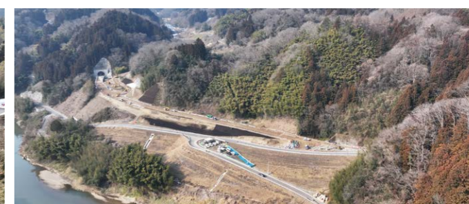
施工状況④ 終点部（丸森町大張川張地区）
