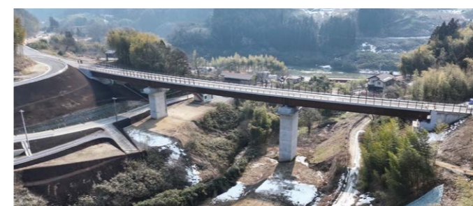
施工状況③ たけのご橋
