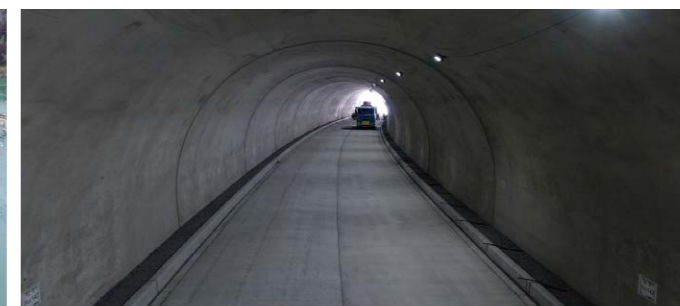
施工状況② 耕野火石坂トンネル
