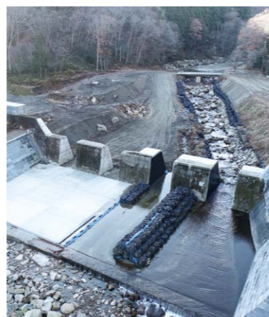
▲スリット化工事（不動尊砂防堰堤）
