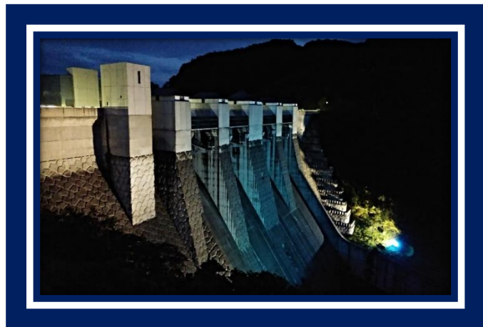
ダム右岸より
