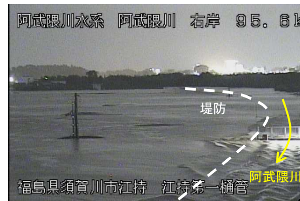
【須賀川市】江持第一樋管(95.6k付近)
