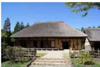
▲釜房の家 (川崎町)
