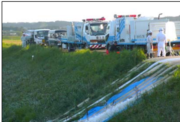
排水ポンプ車による排水作業
