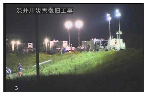
照明車設置による24時間復旧工事
