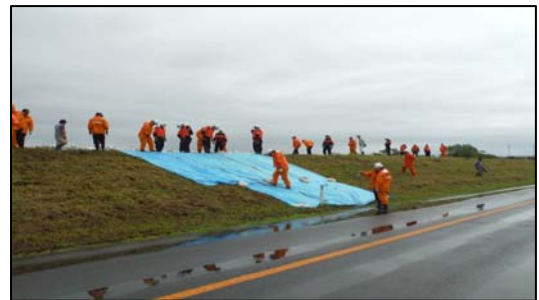
江合川での水防活動（シート張工）
