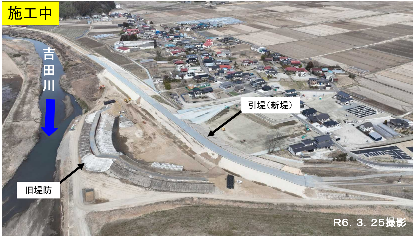
引堤(新堤)施工中 旧堤防撤去前
