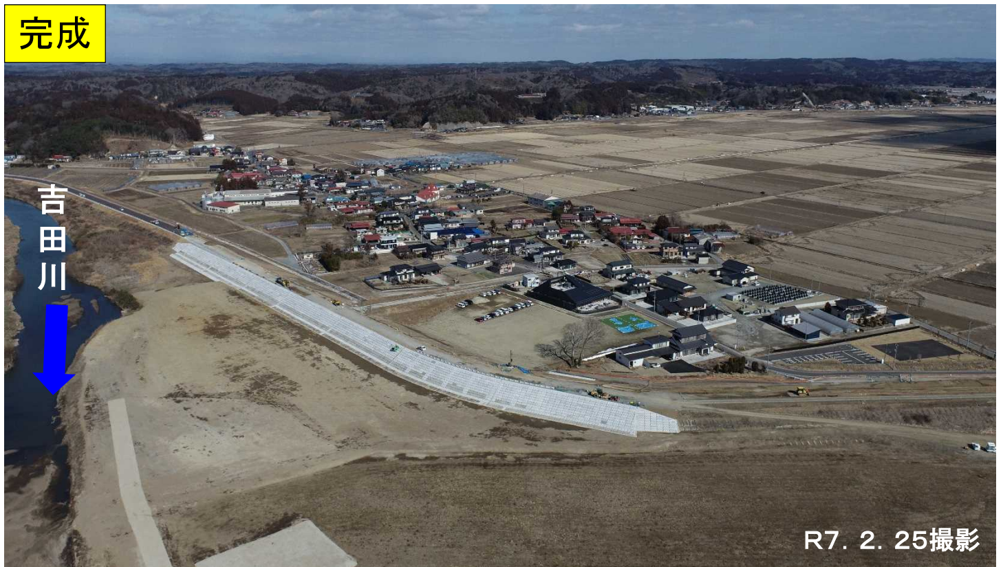
引堤(新堤)完成 旧堤防撤去後
