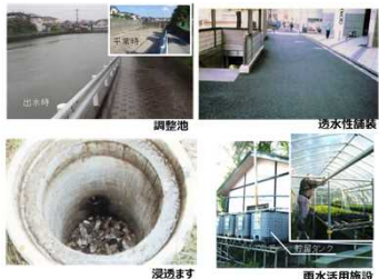
雨水貯留浸透施設の例
