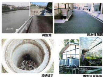
雨水貯留浸透施設の例
