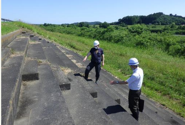
小野歩道橋下流階段護岸（鳴瀬出張所+東松島市）
