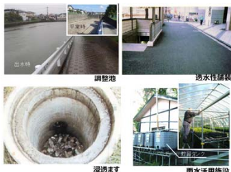
雨水貯留浸透施設の例
