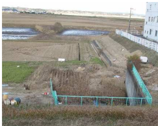
志田谷地排水樋管の法裏部
