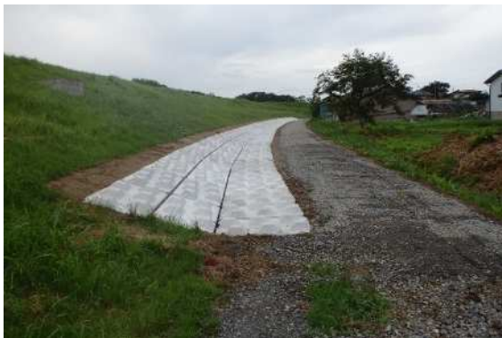
堤防裏法尻の補強
