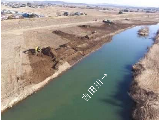
河道掘削イメージ
