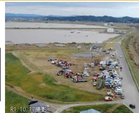
災害時の水防災拠点活用状況
