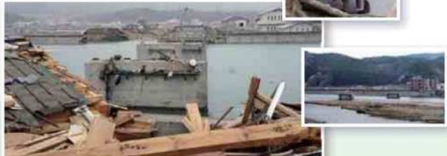
気仙大橋（国道45号）が流出し、橋梁下部に設置されていた中継伝送路が切断（岩手県陸前高田市）
