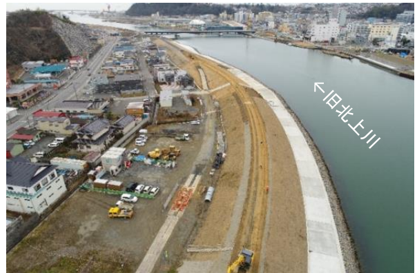
② 左岸不動町地区の堤防整備状況
