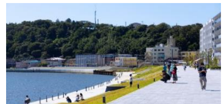
堤防整備状況
