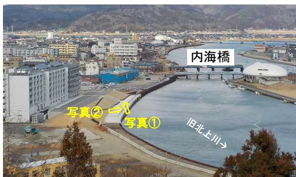
中央地区堤防整備状況
