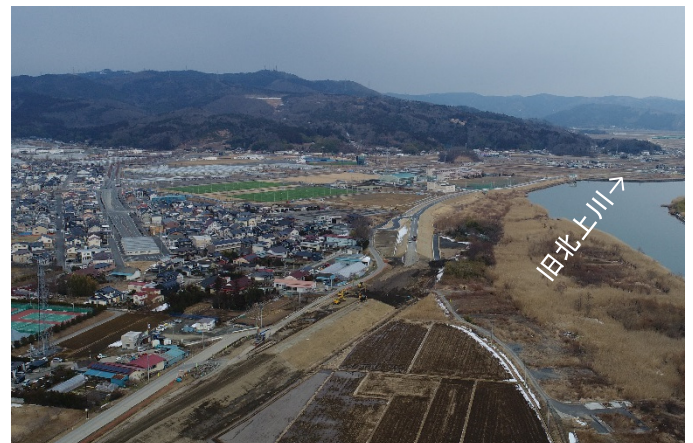
② 左岸南境区の堤防整備状況
