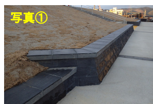
石積護岸整備状況
