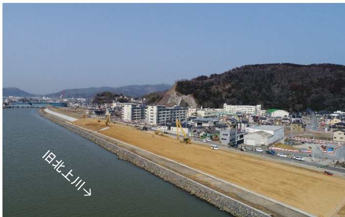
① 左岸湊地区の堤防復旧状況
