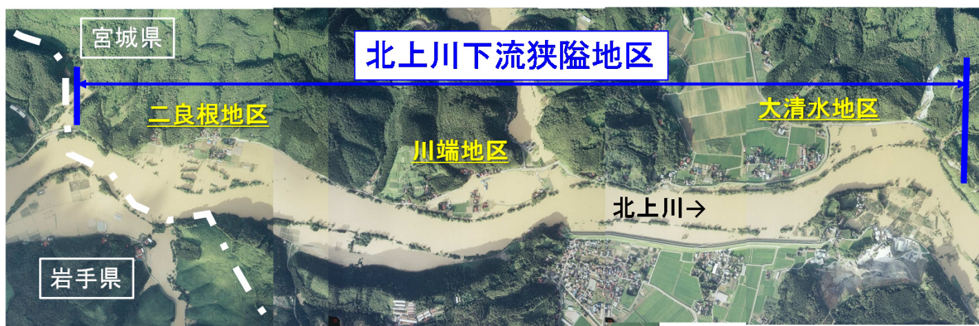
平成14年7月洪水時の状況
