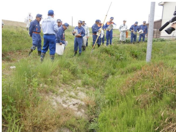
鳴瀬川右岸11.7k_川裏噴砂箇所の巡視
