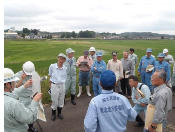
吉田川右岸24.3k_9.11越水箇所の巡視
