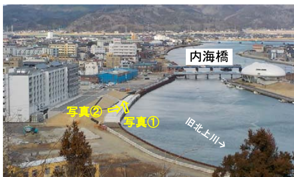
中央地区築堤整備状況
