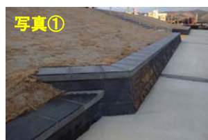
石積護岸整備状況(既往整備)
