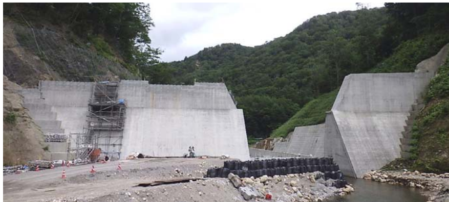
湯ノ倉砂防堰堤(上流から撮影) H28年7月撮影
