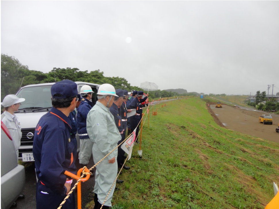
【美里町】 水防団等との合同巡視状況(H27.6.9)
