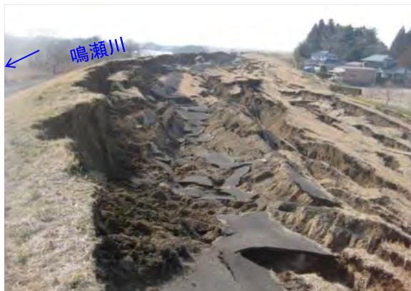
地震により堤体が崩落
