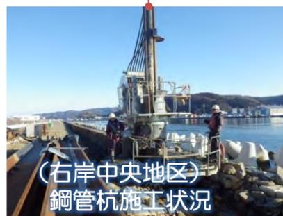
(右岸中央地区) 鋼管杭施工状況
