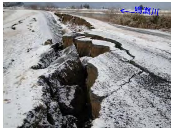
地震により天端沈下と縦断クラック発生
