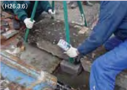
笠石設置状況
