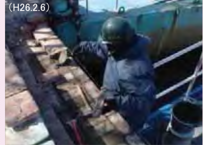
煉瓦補修状況
