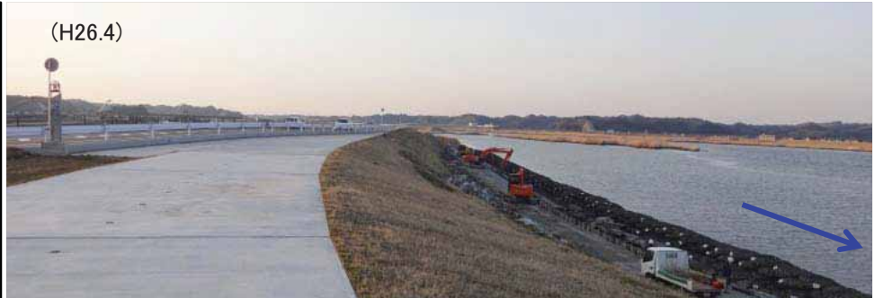
・築堤盛土施工後、川前に作業ヤードを設置
