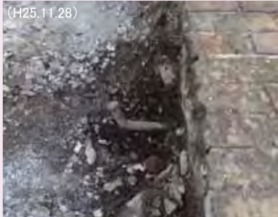
笠石の下のズレ止め鉄筋
