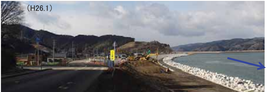
・堤体盛土・ブロック張護岸を施工
