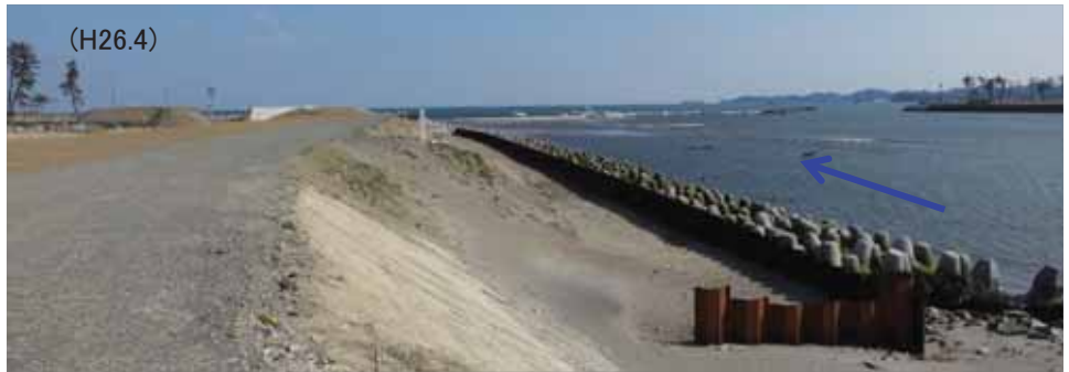
・川前に矢板打設後、根固めブロック据付
