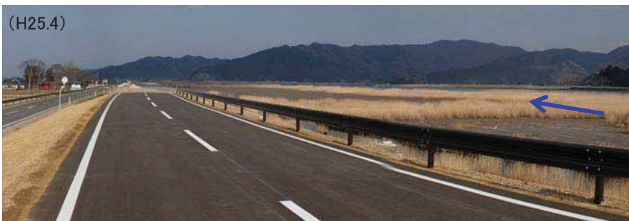
・堤防の復旧が完了
