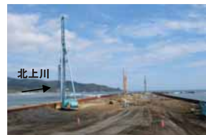
北上川河口部地盤改良の施工状況
