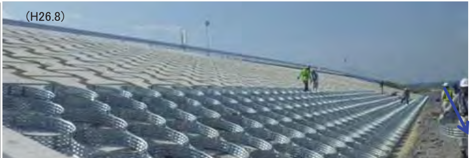
・覆土工(土砂留めリング)を施工
