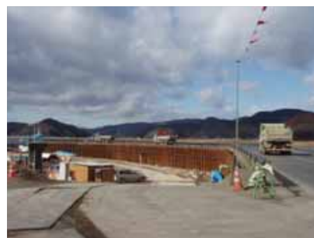
工事用迂回路
