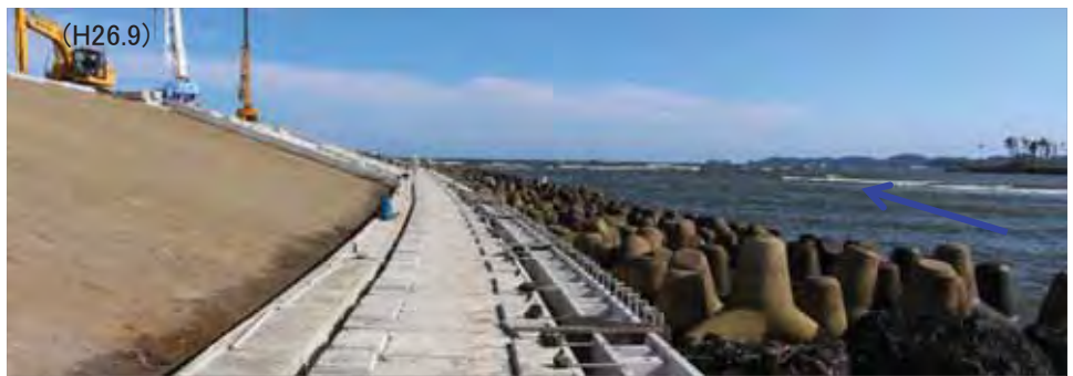
・ブロック張護岸を施工
