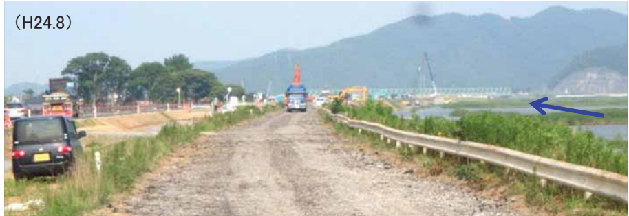
・天端道路を川裏側へ切り回し
