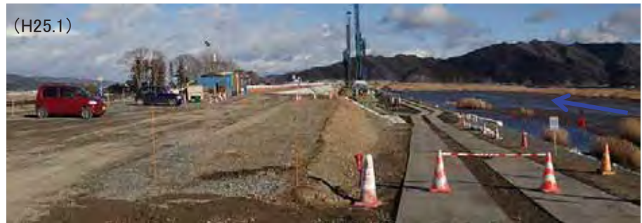
・堤防開削、仮設ブロック張護岸を施工後、地盤改良を施工
