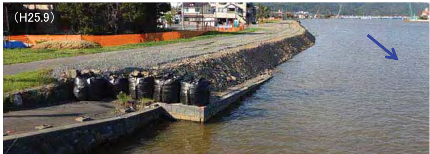
・作業ヤードを兼ねた盛土を施工
