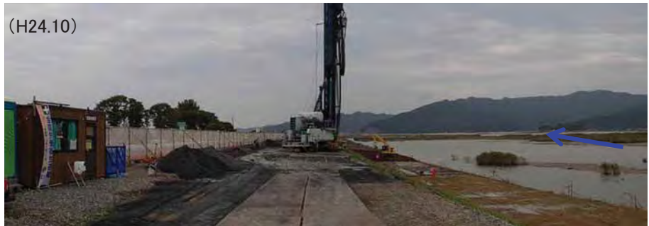
・地盤改良を施工
