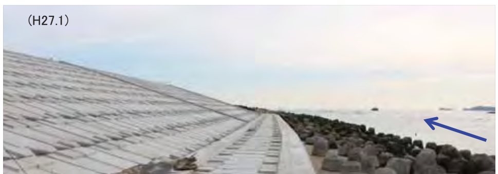
・堤防の復旧が完了
