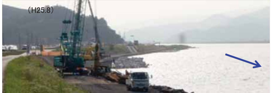
・川前の矢板を施工
