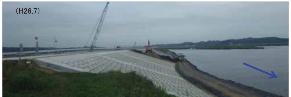
・ブロック張護岸を施工
