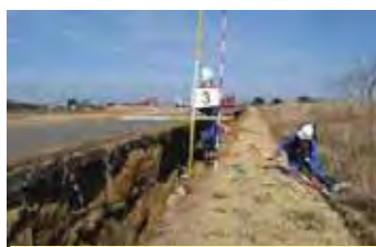
河川被災状況の調査
