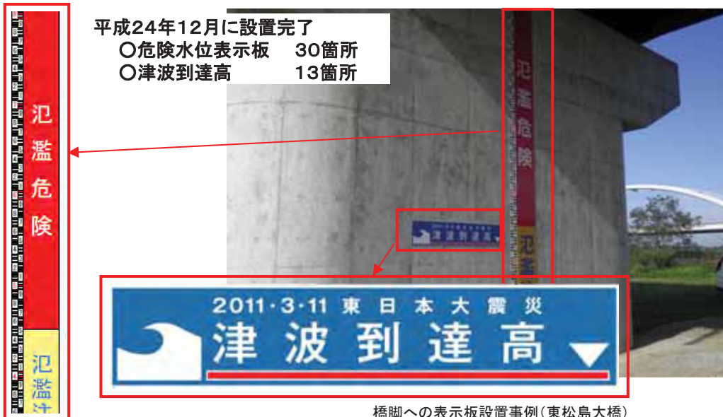
橋脚への表示板設置事例(東松島大橋)
