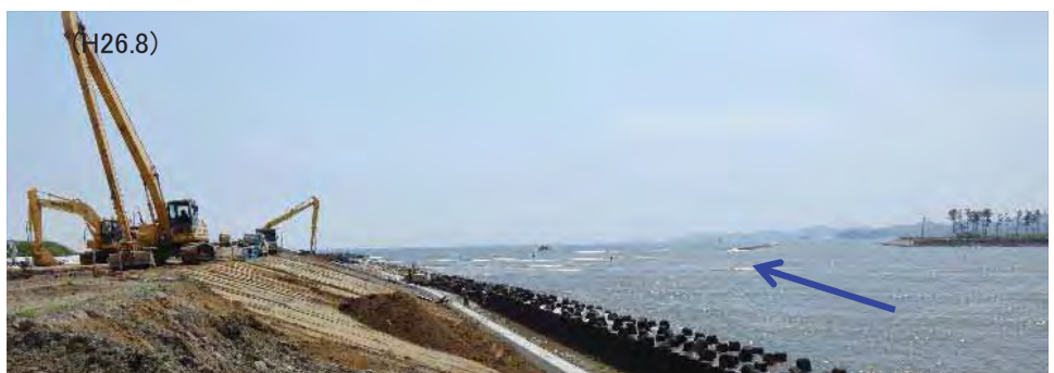
・堤体盛土を施工
