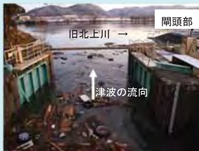
北上運河を遡上する津波で押し開かれた閘門ゲート(H23.3.11 16:09頃)
