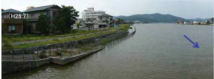
・工事着手前
