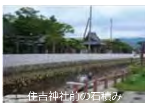
住吉神社前の石積み 石積み護岸の保全・復元
