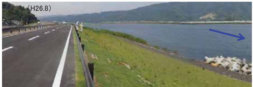
・堤防の復旧が完了
