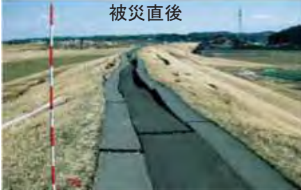
鳴瀬川 (大崎市三本木)
