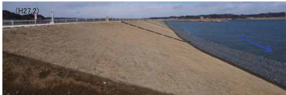
・堤防の復旧が完了
