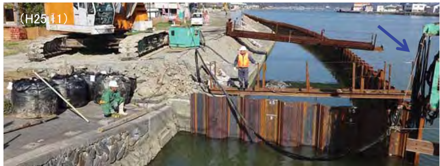
・川前護岸の矢板を施工
