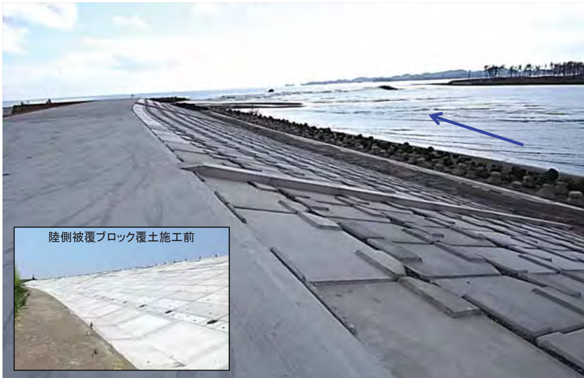
鳴瀬川河口の粘り強い堤防の施工状況(東松島市浜市地区)
