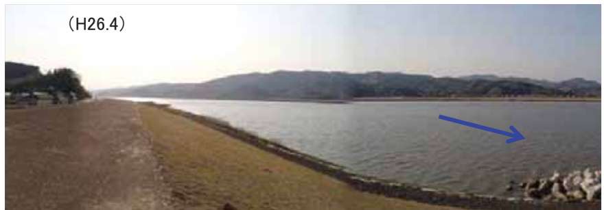
・堤体に張芝を施工
