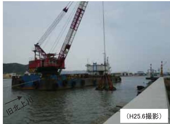
③ 台船による障害物の撤去 (石巻市門脇町地先)
