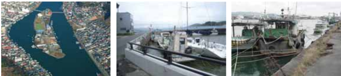
東日本大震災以前の状況
