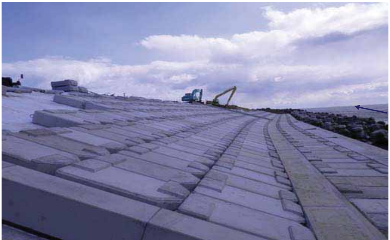
鳴瀬川河口の粘り強い堤防の施工状況(東松島市浜市地区)
