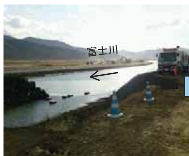
富士川排水状況 (平成26年1月22日撮影)
