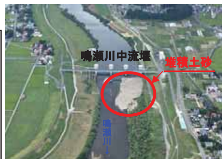
鳴瀬川中流堰の堆積土砂状況 （H24.8.9撮影）
