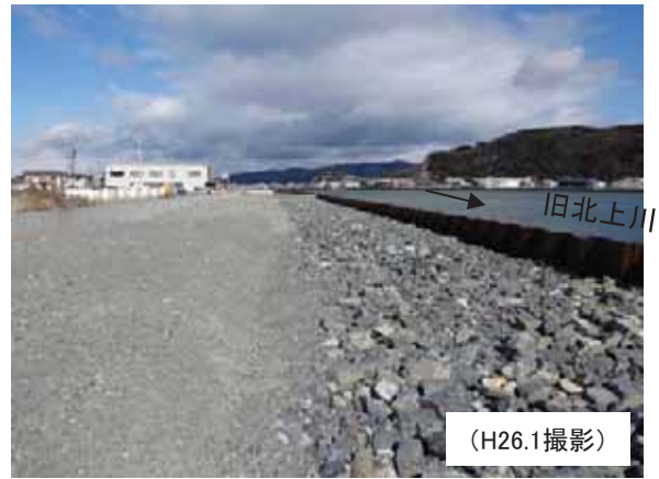
⑤ 矢板施工箇所 (石巻市門脇町地先)
