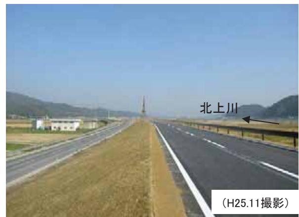
⑤左岸築堤箇所 (石巻市中野地先)
