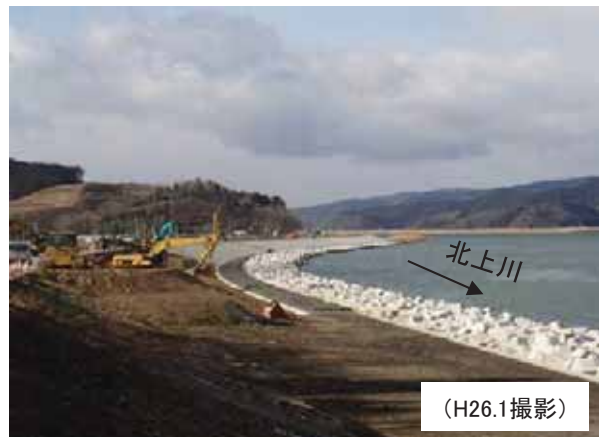
③護岸の施工状況 (石巻市福地地先)
