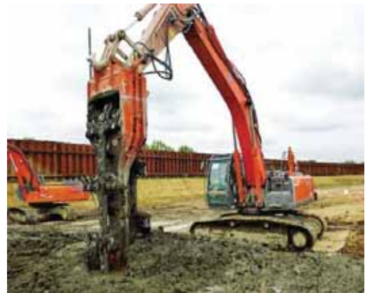
パワーブレンダー工法
