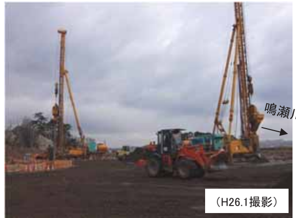
③地盤改良の施工状況 (東松島市野蒜字下沼地先)
