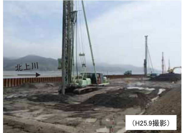
①地盤改良の施工状況 (石巻市長面地先)
