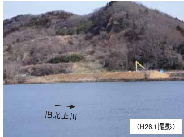
① 築堤の施工状況 (石巻市南境地先)
