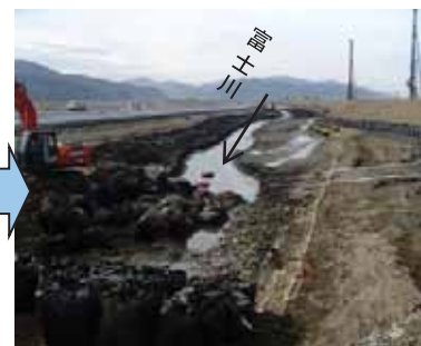
富士川排水状況 (平成26年1月30日撮影)
