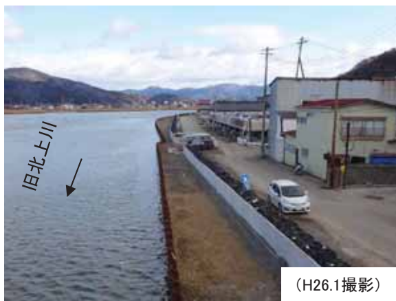
④ 矢板施工箇所 (石巻市不動町地先)
