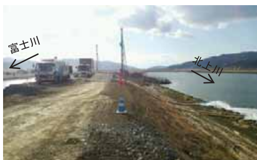
富士川排水状況 (平成26年1月22日撮影)
