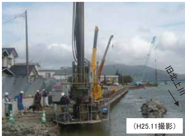
② 矢板の打設状況 (石巻市住吉町地先)
