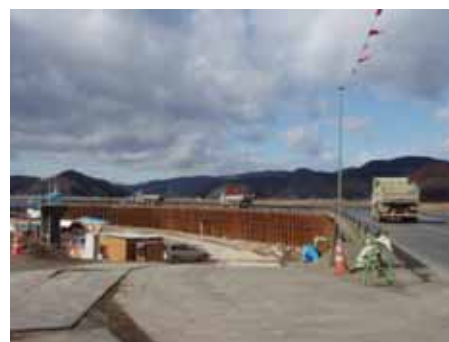
工事用迂回路
