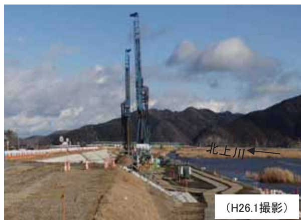
④地盤改良の施工状況 (石巻市北上町橋浦地先)
