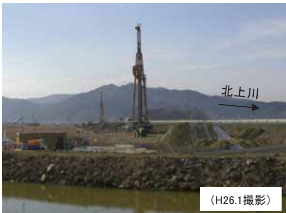
②地盤改良の施工状況 (石巻市針岡地先)
