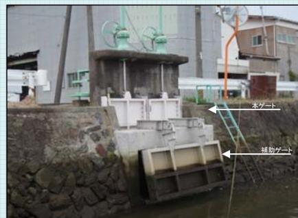
津波に対する操作で、本ゲートの操作が出来ない場合、補助ゲート(フラップゲート)で逆流を軽減するとともに、操作員の安全を確保する。
