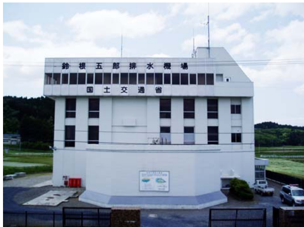
排水機場の補修を実施
