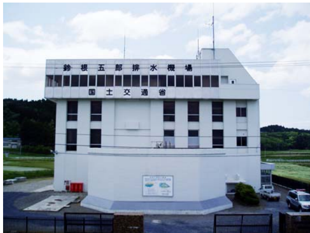
排水機場の補修を実施
