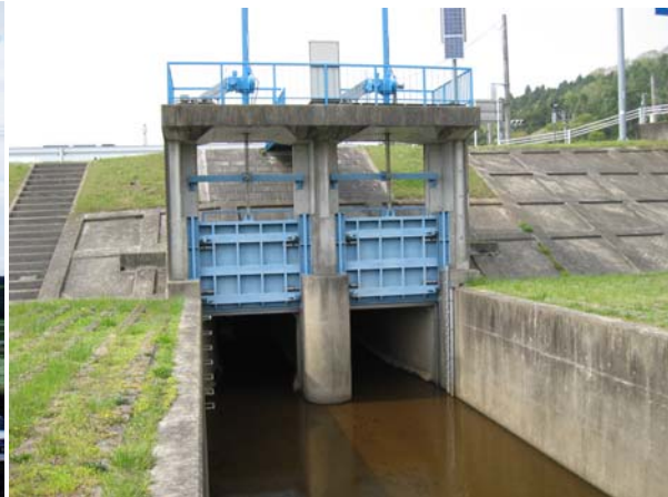
樋門等管理施設のゲート開閉装置の電動化・上屋設置
