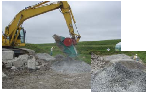
③再生クラッシャーラン(RC-40)製造工
