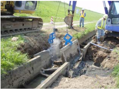
③再生クラッシャーラン(RC-40)製造工
