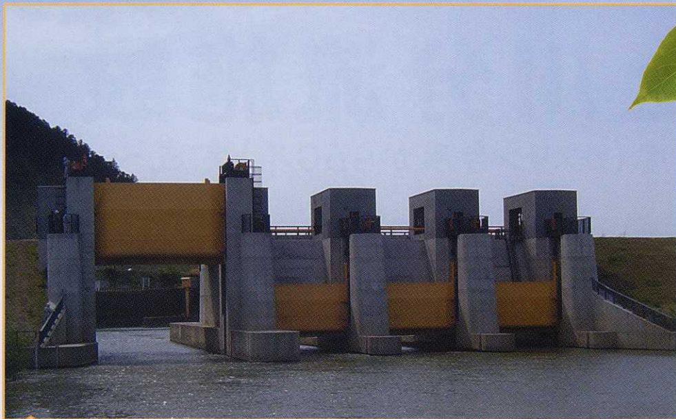
■脇谷水門完成■
