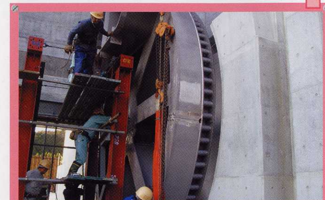
ゲート据え付け中
