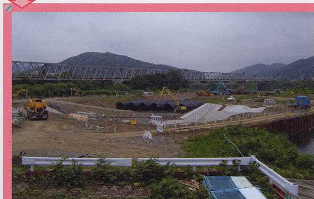
本体工事のため水路を付け替える
