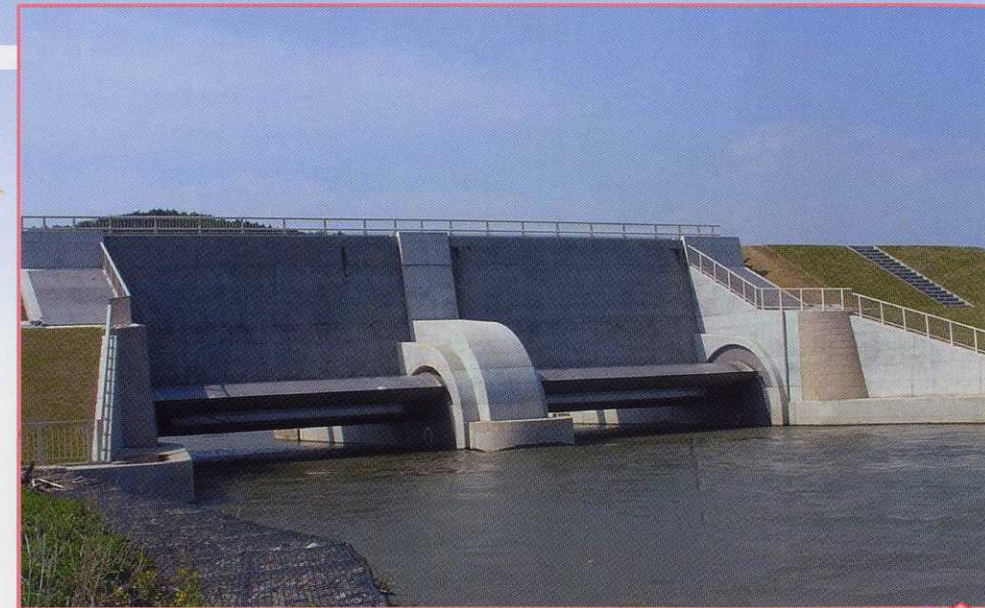
■鷺波水門完成■
