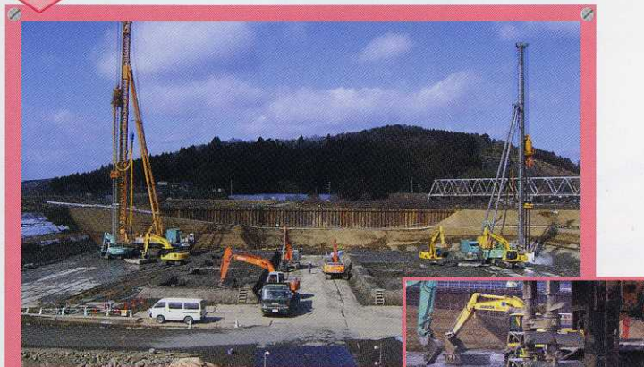
地盤改良工事
