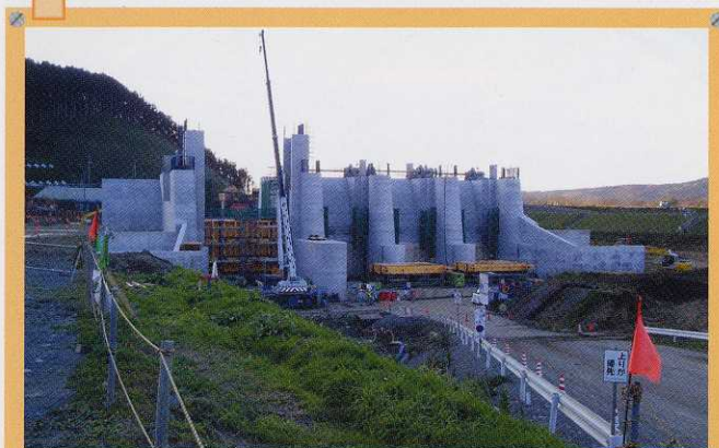
卵色のゲートを据え付け中
