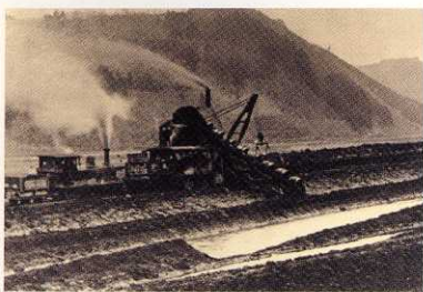
新川櫻崎掘削工事(桃生町)
