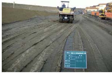
タイヤローラーでの土の締固め
