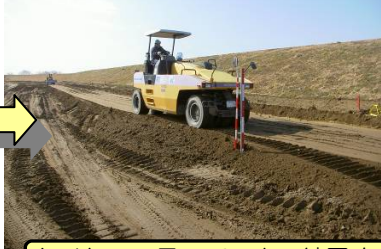
タイヤローラーでの土の締固め
