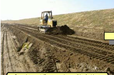
ブルドーザでの土の敷き均し
