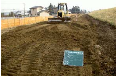
ブルドーザでの土の敷き均し
