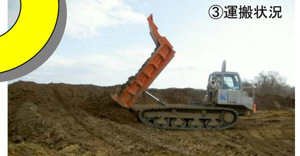
上記写真は、河道掘削から改良までの流れを説明した写真です。（作業順番は、①掘削前状況→②バックホウによる掘削→③クローラータンプによる運搬→④改良機による土質改良）掘削前は雑木で覆われていた岸が伐開・掘削されることによって、河道が広くなり洪水を安全に流すことが可能になります。
